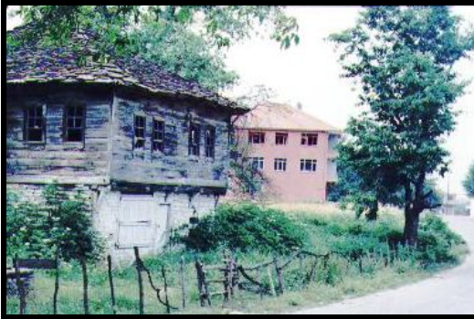
Foto 10. Çatı örtüsünde zaman içinde meydana gelen değişimler; a: Taş örtü üzerine yama yapılmış (1990) b: Aynı evin çatısı kiremitle değiştirilmiş (1997), Kayabaşı köyü (Türkeli). Taş çatı örtülü ahşap evin dışı çinko ile üstü kiremitle kaplanmış (Yenigüler Köyü (Ayancık). e-f: Taş örtülü ahşap meskenler çoğu kez de zamana yenik düşerek taş örtüleri ile birlikte ortadan kalkıyor, Keşköy (Türkeli).
