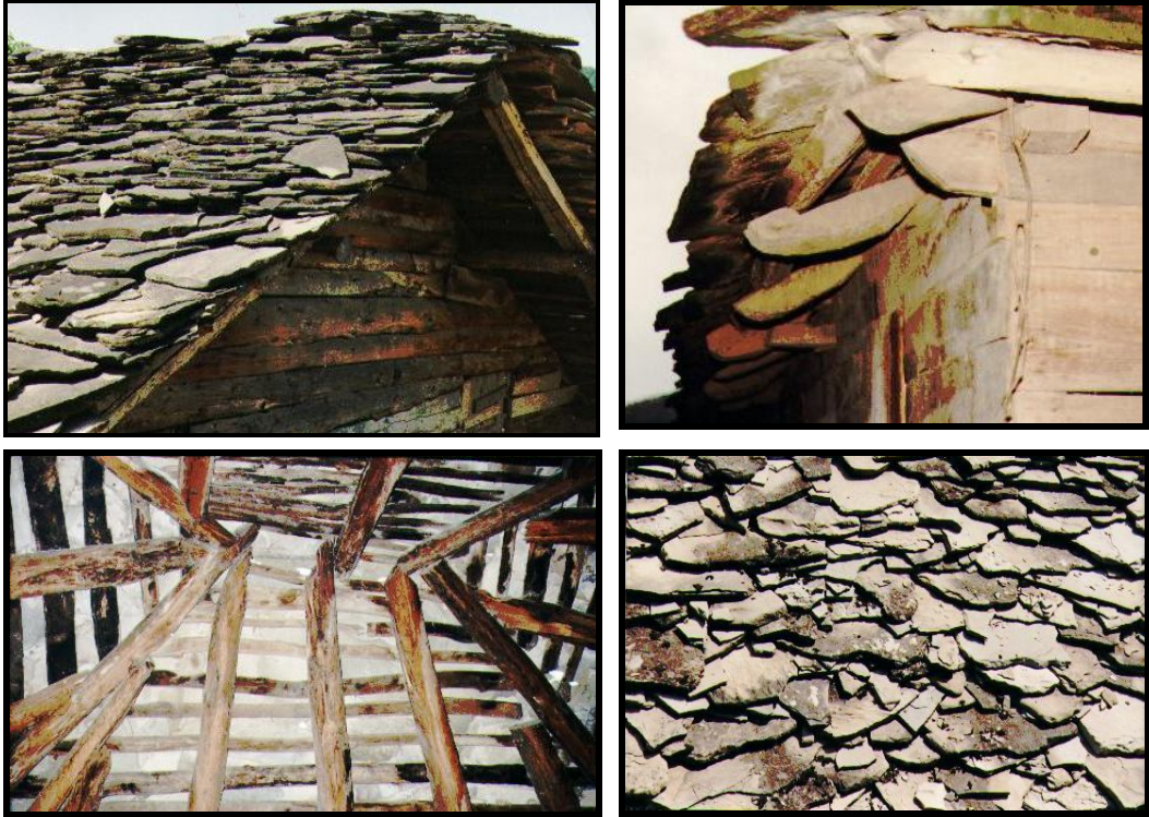
Foto 4. Taş örtünün çatı üzerindeki değişik görünümleri; a: Tabakalı şistlerin beşik örtü tipi bir çatıda kullanılışı, b: Taş örtünün mefekolu uzantıları üzerinde saçaklarda kullanılışı, c: Kırma çatılı bir meskenin çatısının içten görünümü; mefekolları, hartamalar ve taş örtü, d: Taş çatı örtüsünün üstten görünümü.
