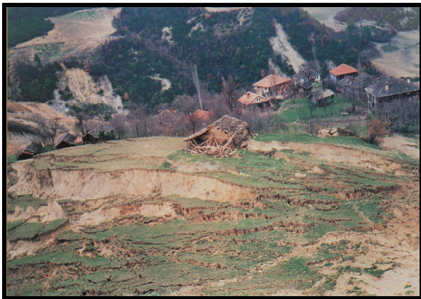
Şekil 4. Babaçay köyü heyelânı (Kaynak: KUTERDEM ve TEMİZ 2001'den). Fig. 4. Babaçay village landslide (Source: KUTERDEM and TEMİZ 2001).
