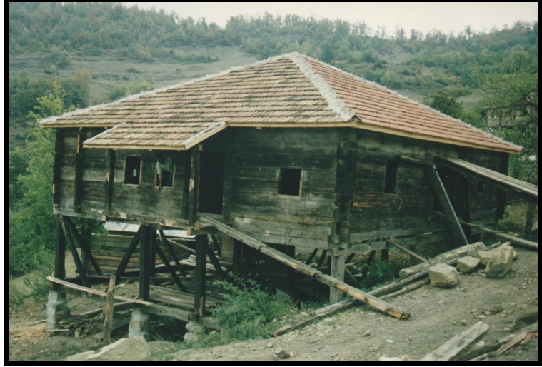
Şekil 13. Çataküney köyünde yeniden inşa edilmekte olan ahşap bir mesken. Fig. 13. A wooden house that is being rebuilt in Çataküney.
