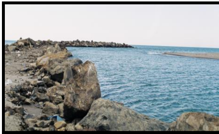
Foto 14. a) Mahuzların yeterli olmadığına anlaşılmaması ile, aşındırma etkisini azaltmak için, Kızılırmak'ın ağız kısmının batısında denize doğru inşa edilen dalgakıran ( Batı mahmuzu ) (kuzeye bakış), b) Yaklaşık 300 m'yi bulan mahmuzun kuzey ucundan güneye ( Bafra Ovası'na ) bakış ve ırmaktan Karadeniz'e çıkan bir balıkçı teknesi.
