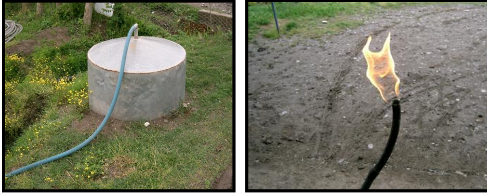
Foto 90. a) Su kuyusu yoluyla tespit edilen gazın üstü örtülerek kontrol altına alınması, b) Kuyudan bir boru vasıtası ile evlerdeki ocaklara kadar ulaştırılan ve kontrollü bir şekilde kullanılan gaz. (Kaynak: ANONİM).
