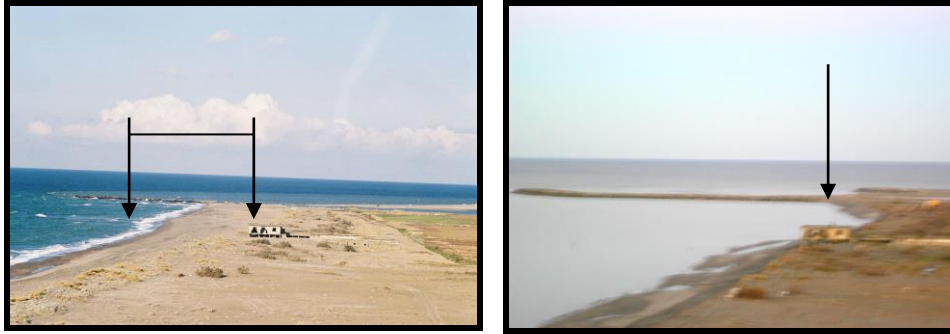
Foto 17. a) 9 Ağustos 2002'de Bafra Deniz Feneri'nin balkonundan KD'ya bakış. Mahmuz inşaatı devam ediyor. Ok ile gösterilen bina ile kıyı çizgisi arasında yaklaşık 100 m mesafe var. b) (4 yıl sonra) 16 Aralık 2006 tarihinde aynı yerden çektiğimiz fotoğrafta mahmuz inşaatı bitmiş. Kıyı çizgisi ile bina arasında kalan arazi erozyonla aşınarak yok olmuş. Dalgalar binaya vuruyor.
