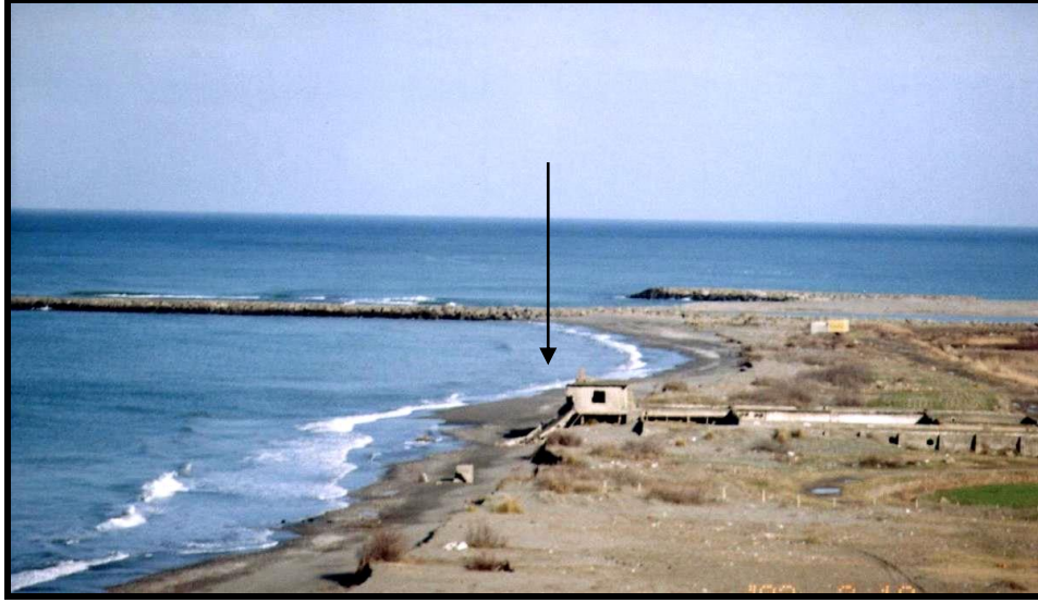
Foto 18. (Foto 17b'nin çekilmesinden 20 gün sonra) 6 Ocak 2007'de yine aynı yerden (Bafra Deniz Feneri balkonundan) çekilen bu fotoğrafta dalgalar binanın yarısını yıkmış, geri kalanı da tahrip etmek üzere (Foto: Feriştat Özman) 4 . Mahmuz inşaatından sonra ortaya çıkan bu durum son derece dikkat çekici.
