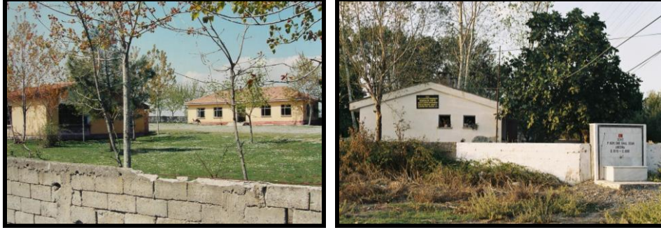
Foto 40. a) Taşınmalı sisteme geçilmesi ile birlikte terk edilen Üçpınar köyü ilkokulu. (Talep olduğunda devlet bu tür boş okul binalarını iktisadi faaliyetlerde bulunmaları koşuluyla özel sektöre kiraya verebilmektedir). b) Koruluk köyü Şehit Engin Kahraman birleştirilmiş sınıflı ilköğretim okulu.
