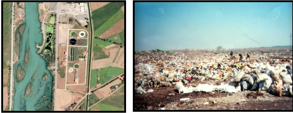
Foto 65. a) Kızılırmak kıyısında inşa edilen arıtma tesislerinin uydudan görünümü, b) Katı atık döküm sahasında vahşi depolama.
