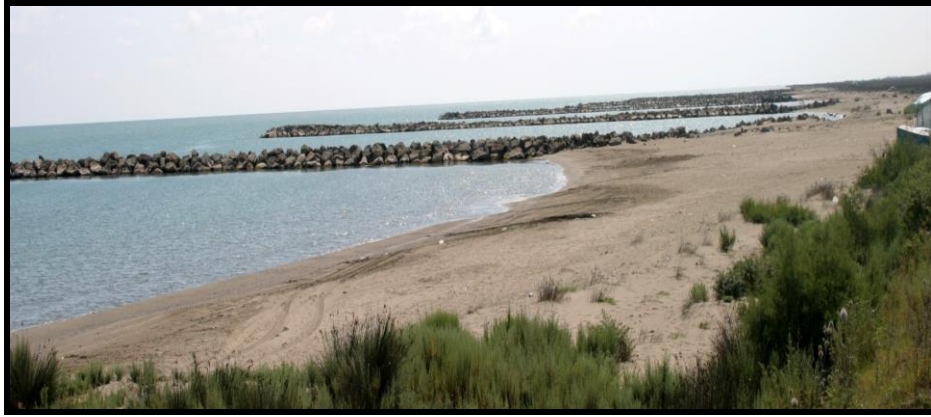
Foto 13. Daha doğuya doğru inşa edilen I şekilli 4, 5, 6, 7 ve 8 no.lu mahmuzlar.
