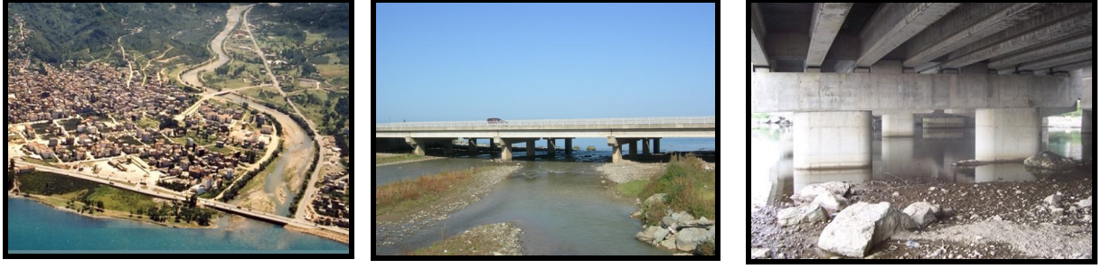
Foto 2. Karadeniz Sahil Yolu güzergâhındaki hemen bütün köprülerin ortak özelliği; yolun yükselti seviyesine bağlı olarak alçak inşa edilmiş olmaları ve sel-taşkın durumlarında tıkanma riski bulunmalarıdır. a) Setlerle kontrol altına (?) alınmış ırmak yatağı ve sahilde Karadeniz Sahil Yolu geçiş köprüsü (Fatsa). b) Sürmene köprüsü genel görünümü. c) Bulancak köprüsü alttan görünümü.
