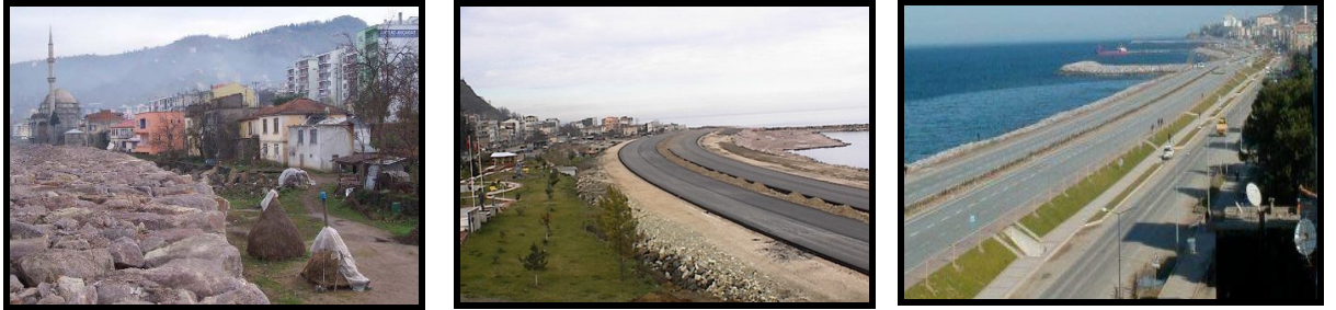
Foto 3. İnşa safhası ve bitirilerek trafiğe açılmış hali ile yükseltilmiş yola Karadeniz Sahil Yolu'nun Giresun ili sınırları içinde kalan değişik kesimlerinden örnekler. Yükseltilmiş yol özellikle yerleşim alanlarında aşırı yağışlarda biriken yüzey sularının doğal akışla denize tahliyesini engelleyerek sorun yaratmaktadır.
