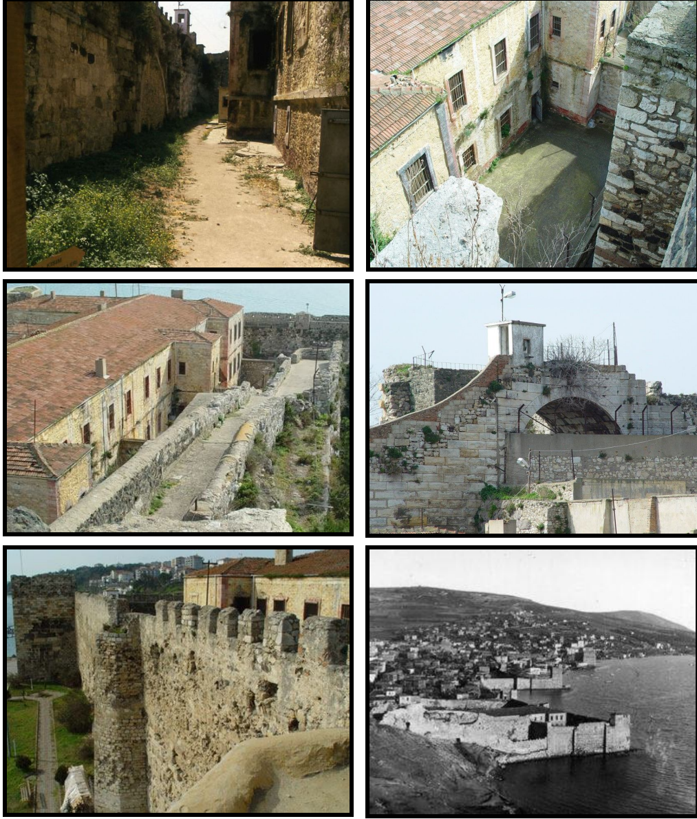
Foto 7. Cezaevini kaçılamaz yapan güvenlik duvarları; a ve b) İç bahçe duvarları, c ve d) Dış duvar üzerindeki güvenlik yolu ve nöbetçi kulübeleri, e) Yüksek dış surlar, f) 1970'li yıllara kadar güneydeki bu surların dibine dalgalar vuruyordu. (Günümüzde buradan yol geçirildiği için artık “dışarıdaki deli dalgalar gelip duvarları yalamıyor”). (Kaynak: Sinop Valiliği).
