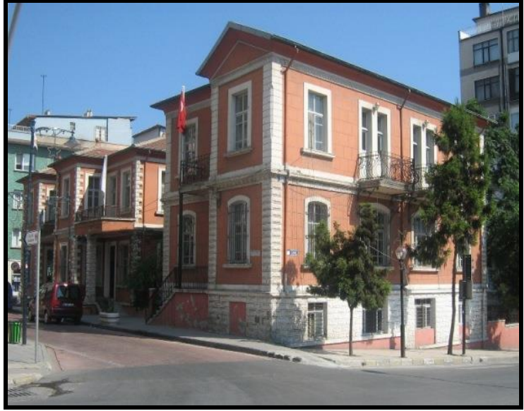
Foto 11. Kent Müzesi olarak kullanılmak üzere restore çalışmaları devam eden eski Konservatuar binası
