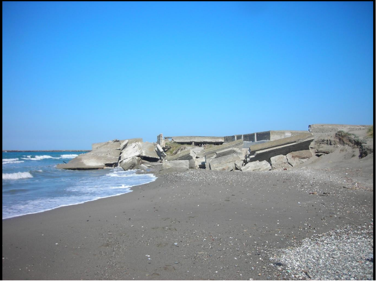
Foto 5. 10.4.2009 tarihinde kıyı çizgisinin Kızılırmak'ın denize döküldüğü saha batısında yer alan eski balık üretim tesisine kadar ulaştığı gözlenmektedir.
