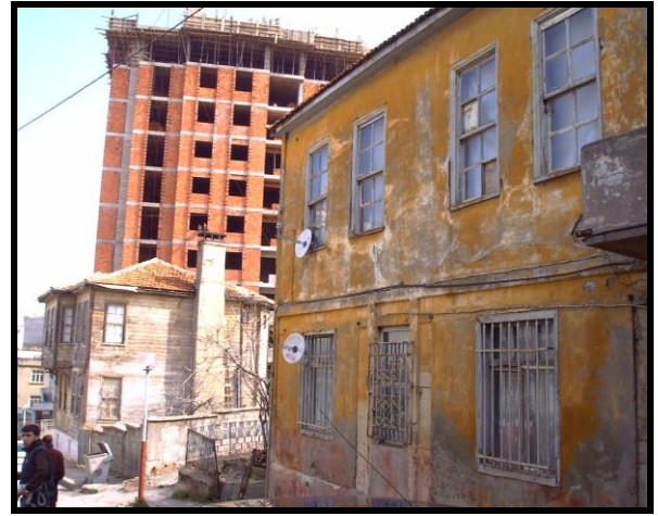
Foto 12. Apartmanlara yenik düşen eski mahalleler ve meskenler.
