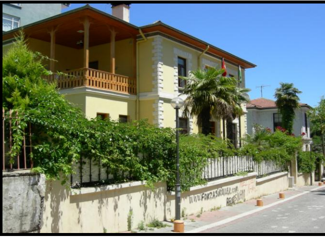
Foto 11. Sanat Sokağı'nda restore edilerek koruma altına alınan eski meskenler.
