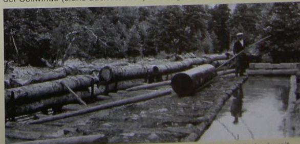
Abb. 102 Der Baumstamm liegt zur Verladung auf die Waldbahn bereit. Die Verladung auf die Trucks erfolgt per Muskelkraft über die bereitliegenden Stangen.
