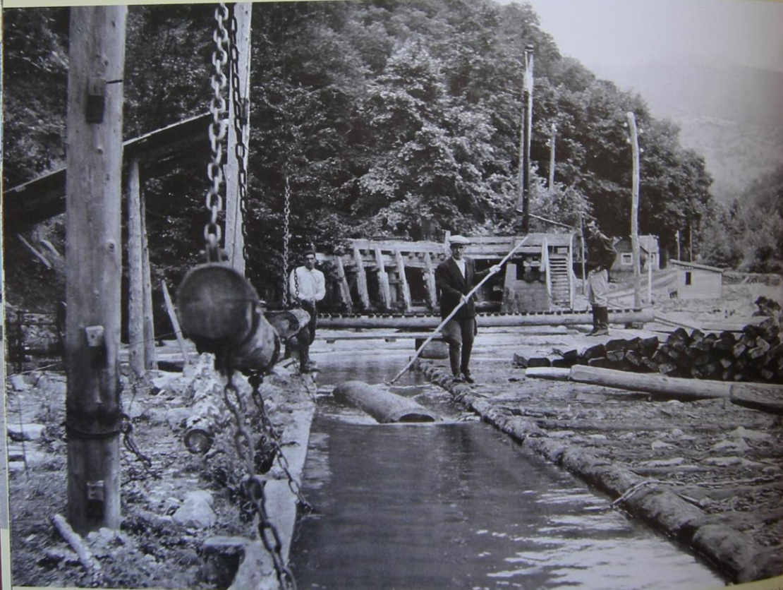
Abb. 92 Übersicht über die Station von Yenice. Im Vordergrund der Schwemmkanal mit den Seilwinden (links) und dem Holzlager (rechts); im Mittelgrund die Entladestelle und im Hintergrund rechts das Stationsgebäude. Der Bremsberg erreichte die Station von links. Gut ist der einzelne Arbeiter zu erkennen, der einen Baumstamm zur Verladestelle treidelt. Auch schwere Lasten lassen sich so durch nur einen Arbeiter bewegen.
