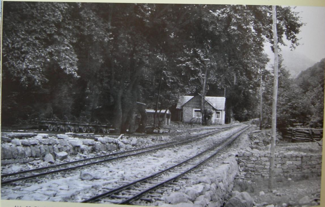
Abb. 99 Die Station bildet den linken Bahnhofskopf. Rechts das Ausweich- und Umfahrgleis, links das Gleis zu Entladestelle und Bremsberg.
