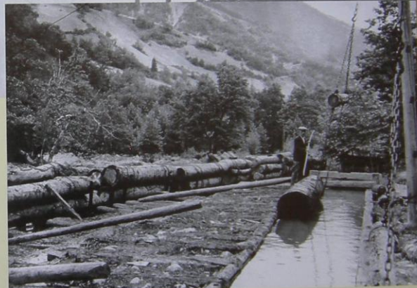
Abb. 101 Der Bloch wird im Schwemmkanal zur Verladung vorbereitet. Der Arbeiter hat den Bloch über den Ketten zentriert, nun wird er mit Hilfe der Seilwinde (siehe auch Abb. 87) herausgehoben.
