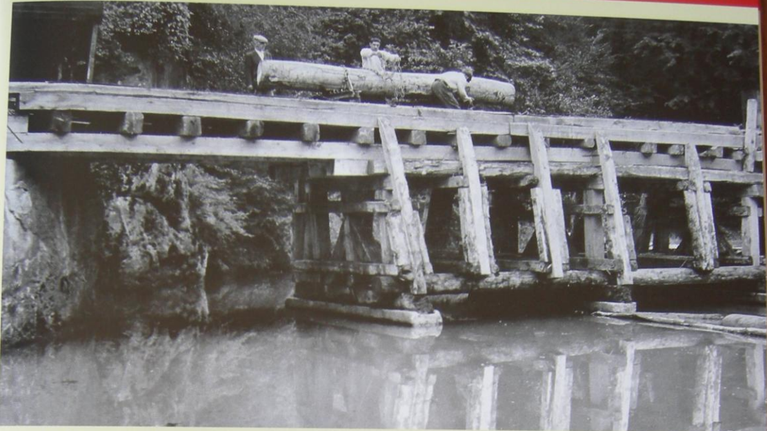
Abb. 96 Ein Paar Trucks mit einem Bloch wurde den Bremsberg heruntergelassen und von den Arbeitern zur Entladestelle auf einer Trestlebrücke geschoben.
