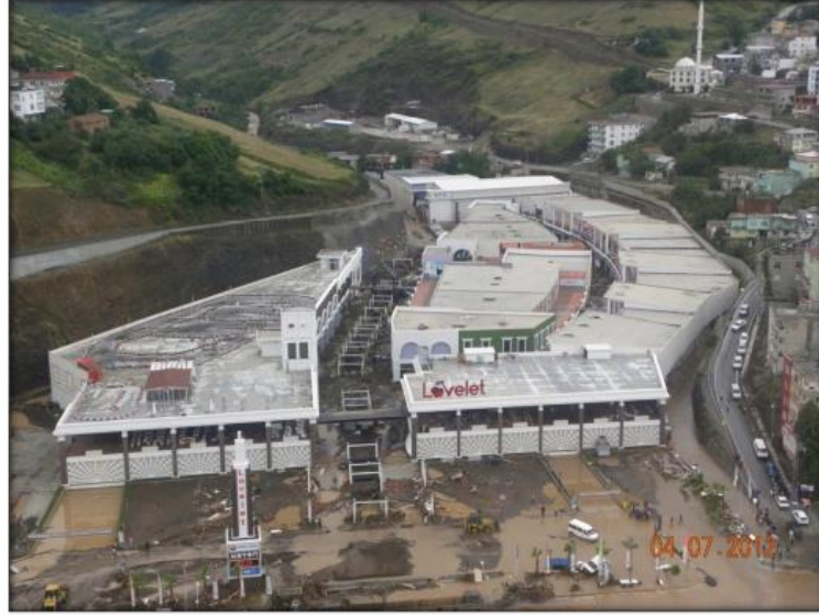
Şekil 6. Devgeriş Deresi'nin taşması sonucu, akarsu yatağı ağzına inşa edilmiş alışveriş merkezinde sel suları özellikle alt katlardaki işyerlerinde büyük maddi kayıplara sebep olmuştur.
