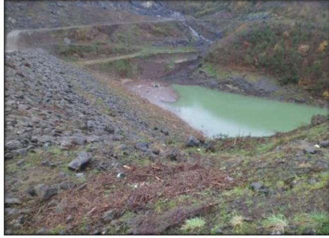
Şekil 3. 4 Temmuz 2012 tarihinde Samsun'da yaşanan selde Yılanlıdere üzerine yapılan sel kapanının tahrip olması ve gerisinde biriken suların hızla boşalması da afetin boyutlarını artırmıştır (S. Gün).
