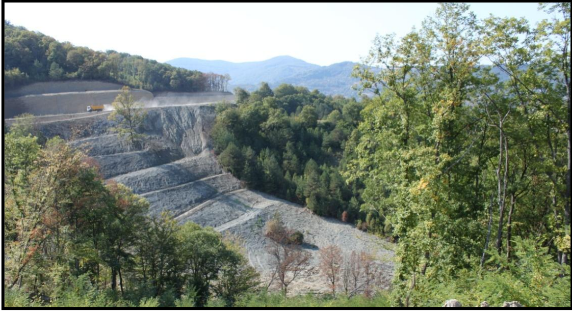
Şekil 9. Yamaca biriktirilen hafriyat yağışların da etkisiyle eğim doğrultusunda hareket etmiştir
