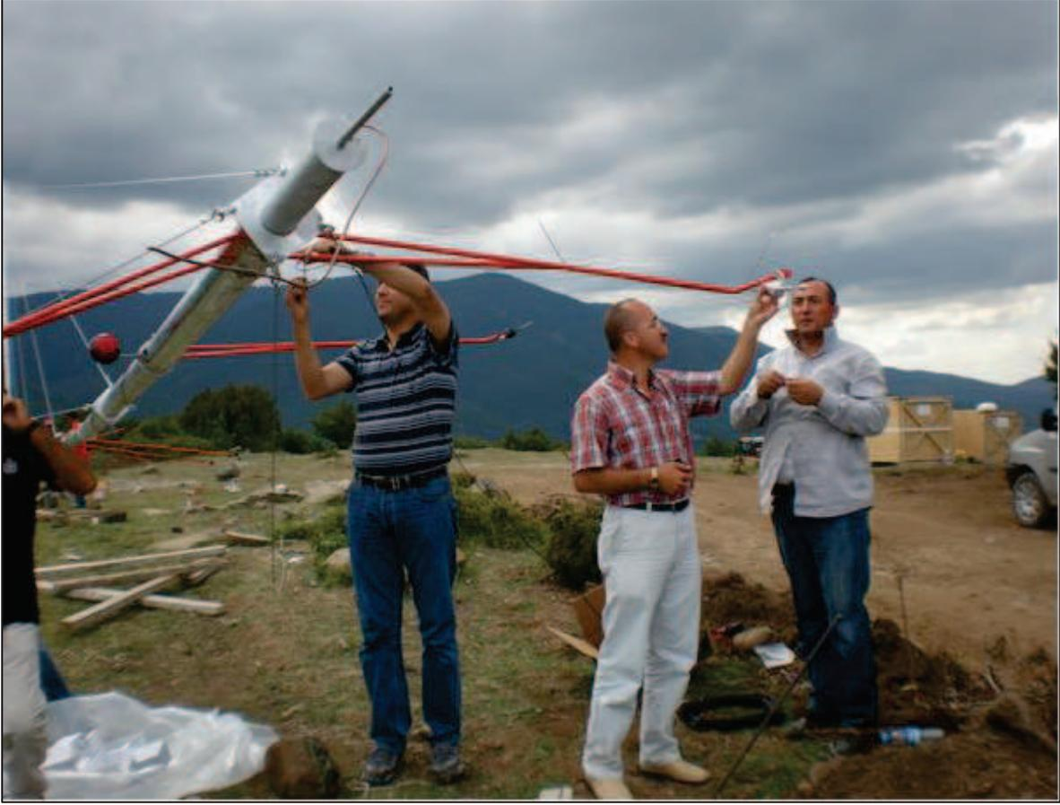
**Foto 1.** İnceleme alanında rüzgâr potansiyelini belirlemek amacıyla kullanılacak ölçüm direğine, dikilmeden önce anemometre ve yön sensörleri monte edilmiştir.
