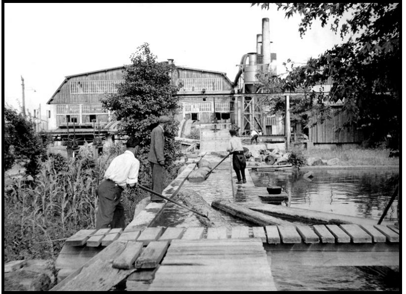
Foto 8. Havai hat ve dekovillerle fabrika bahçesine ulaştırılan tomrukların burada havuzlarda biriktirilmesi, ardından tomrukların cinslerine göre sert (kayın) ve yumuşak (çam, ladin) olarak gruplandırılması, sonra da her grubun kendine ait kanal yoluyla havuzlardan gönderlerle hareket ettirilerek, biçilmek için makinelerin ağızına verilmek üzere buhar gücüne bağlı olarak çalışan demir kancalarla fabrika içine çekilmesi.
