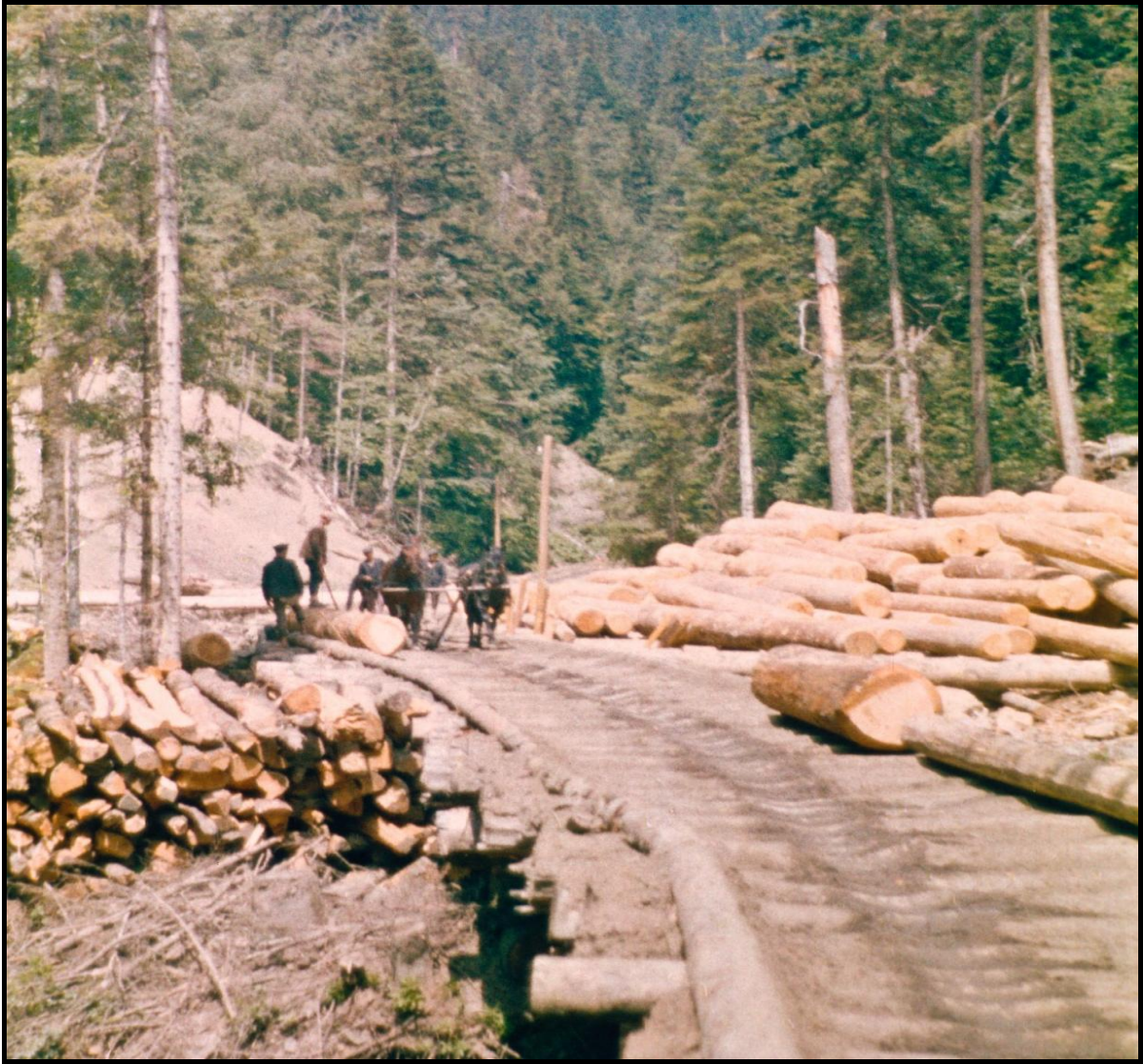
Foto 6. Havai hat, dekovil ve havuz sistemini destekleyen öküz, manda ve atların kullanıldığı sürütme yolları. Sürtünmeyi azaltarak tomrukların zarar görmesini engellemek için bu yolların önemli bir kısmında ağaç kütükler kullanılmıştır.
