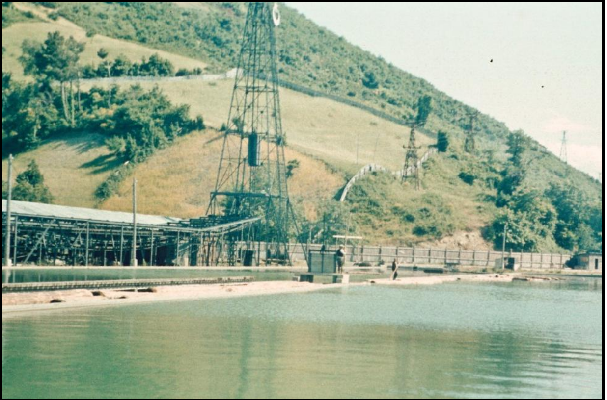
Foto 1. Çangal ormanlarından Fabrika bahçesindeki havuzlara havaî hat üzerinden tomruk nakli.
