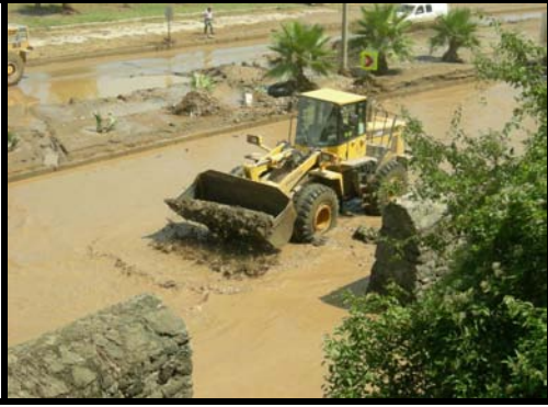
Foto 7. Menfezlerinin yetersiz kalması nedeniyle Baruthane deresinin suları karayoluna dolmuştur.
