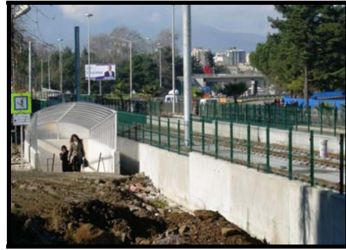
Foto 12. OMÜ Eğitim fakültesi önünde Raylı sistem yolunun kenarındaki beton duvarlar ve alt geçidin girişi.
