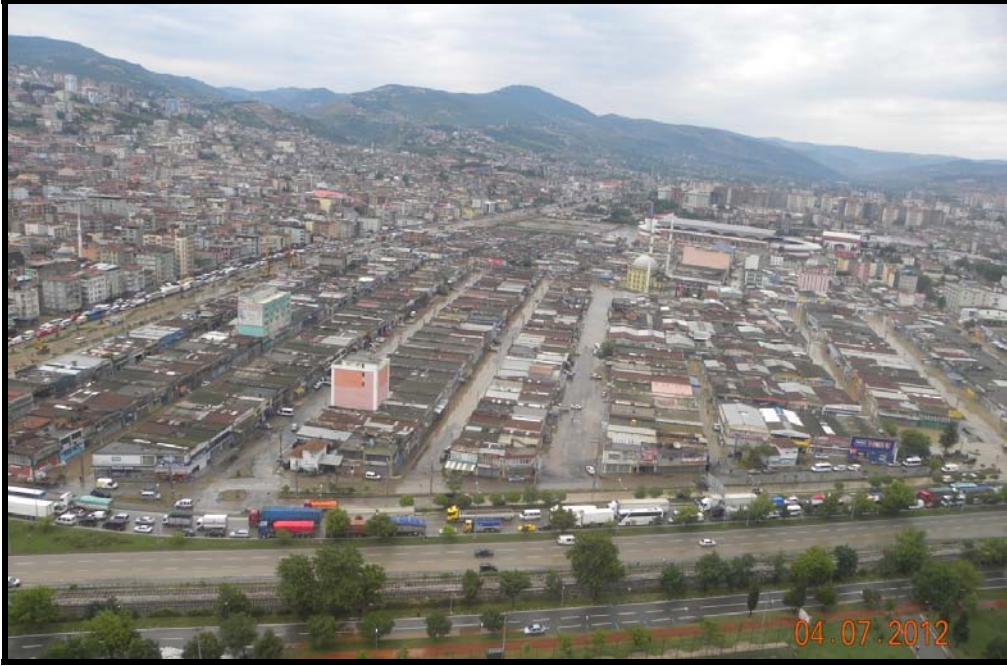
Foto 7. 4 Temmuz 2012 tarihli Samsun şehri taşkınlarında sanayi sitesindeki çok sayıda iş merkezi sel sularının işgaline uğramıştır.
