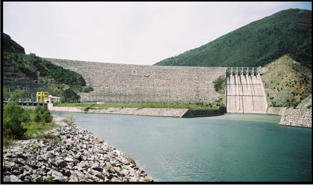
Foto 2. Kızılırmak üzerindeki önemli barajlardan biri: Altınkaya barajı.
