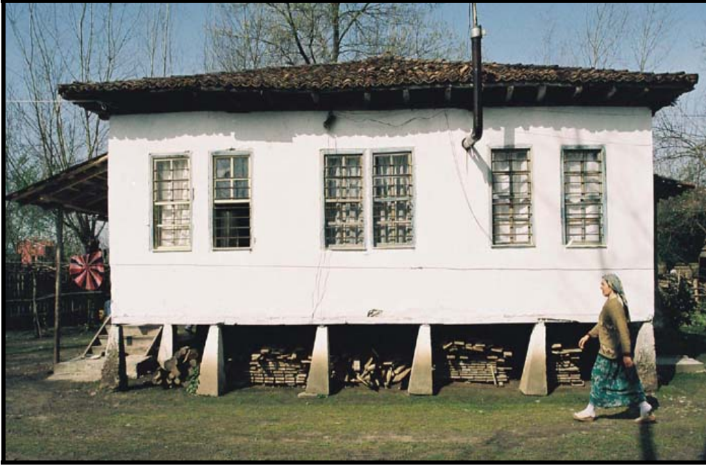
Foto 7. Taban suyunun olumsuz etkilerini azaltmak amacıyla yerden yüksekte yapılan geleneksel delta evlerinden biri. İbrahim Aydın'ın evi Melih köyü, Çarşamba.
