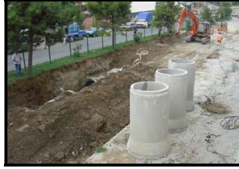
Foto 8. Selden sonra Barış bulvarın-da döşenen beton borular.
