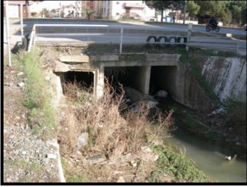
Foto 5. Samsun-Bafra karayolunun Atakent kavşağında derenin geçişi için bırakılan üç gözlü menfez.
