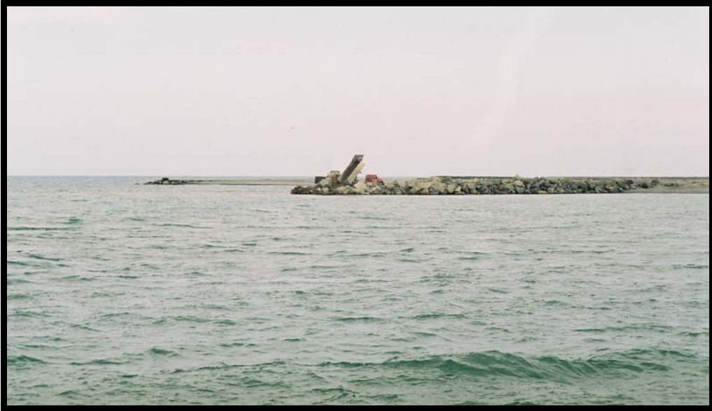
Foto 3. Kızılırmak deltasının gerilemesini önlemek amacıyla akarsu ağzının doğusunda inşa edilen mendireklerden biri.
