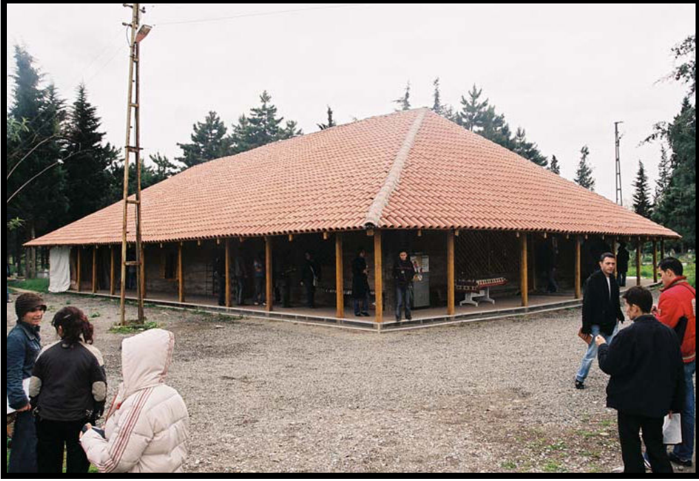
Foto 11. Göğceli Camii. Çarşamba şehir mezarlığında bulunur. 1205'te ahşap malzemeden yapılmış ve 2005 yılında büyük bir tamir görmüştür. İnşasında metal çivi kullanılmamıştır. Caminin üstü kiremit örtülüdür.
