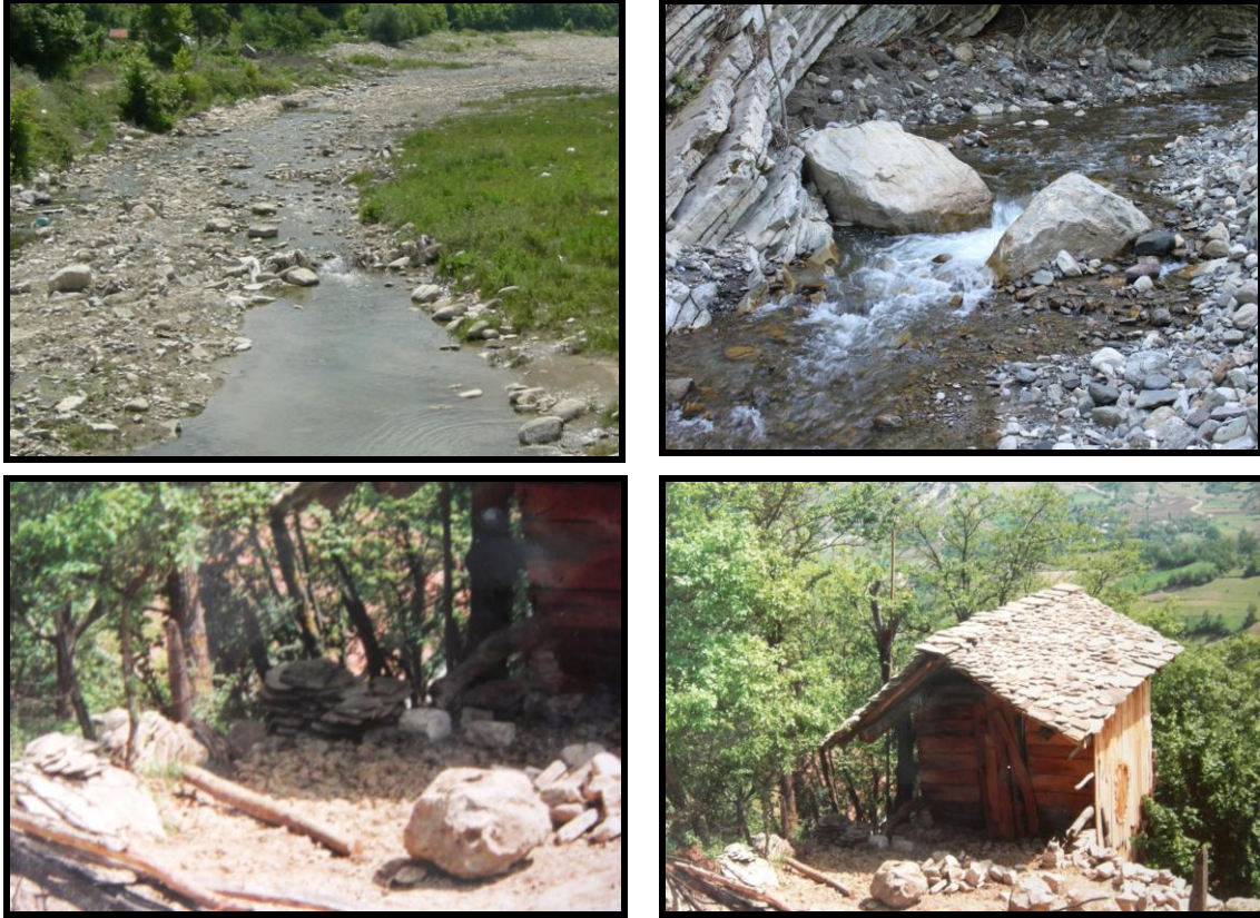
Foto 11,12,13,14. Türkeli Çayı vadisinde taş blokların bulunuşu ve bunlardan bir kaçının köye getirilmesi ve burada dilimlenerek Samanlık üzerinde kullanılması (Yazıcı köyü, Türkeli).
