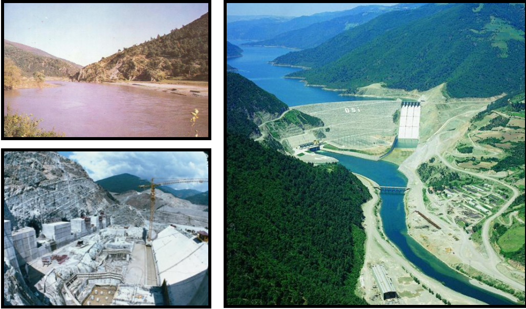
Foto 1, 2, 3. Altinkaya baraj inşa yerinin ilk hali, baraj inşaatı, baraj ve baraj gölünün bugünkü görünümü (güneye bakış).
