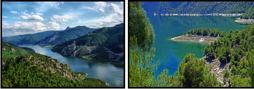
Foto 57, 58. Altinkaya baraj gölü ye yer daralan, fakat çoğunlukla geniş vadiler arasında uzanır ve maviyle yeşilin buluştuğu muhteşem bir manzaraya sahiptir.
