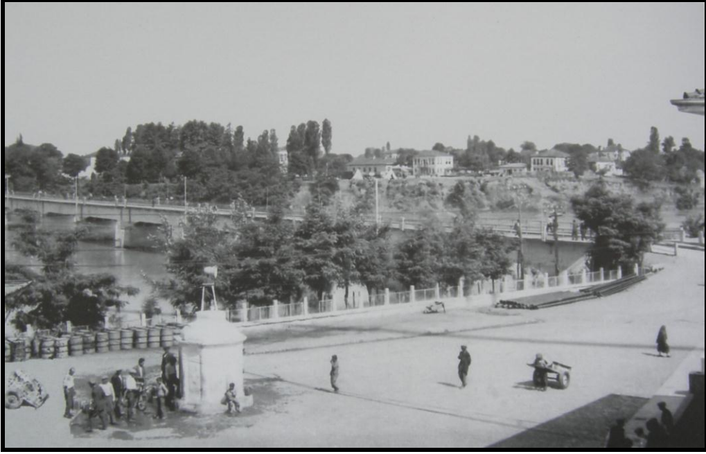
Foto 26. Emirhan çeşmesi ve Çarşamba Köprüsü (ÇTSO Arşivi).
