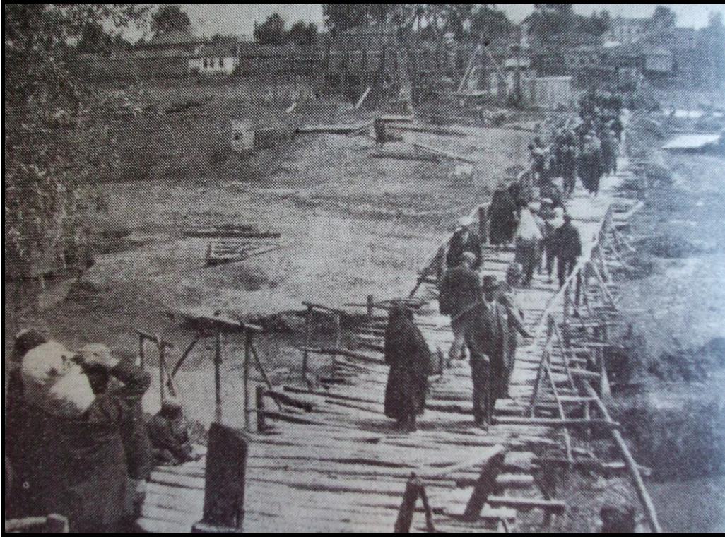
Foto 9. Betonarme köprünün inşaatı devam ederken geçici olarak kullanılan ahşap köprü (Anonim).
