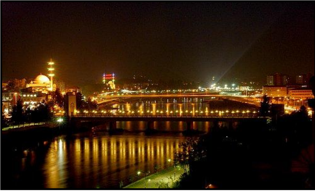
Foto 39. Çarşamba Köprüsü gece görünümü, 2013 (Çarşamba Belediye Arşivi).
