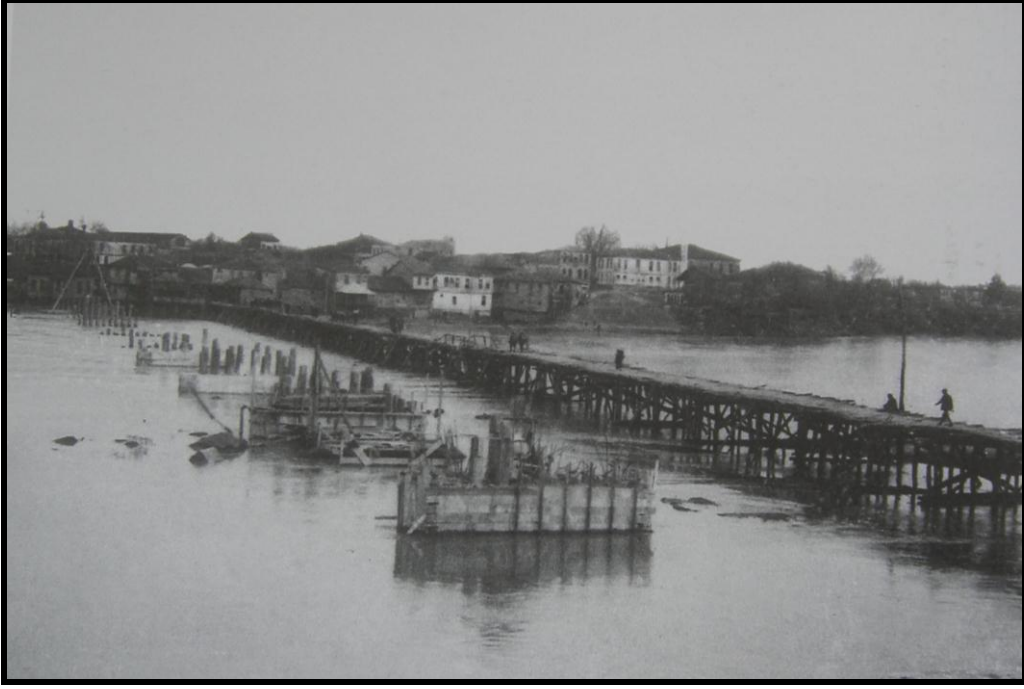
Foto 12. Her selden sonra onarım geçirek ayakta kalmayı başaran tahta köprünün son zamanları, solda beton köprünün temelleri (Çeviker 1992'den).
