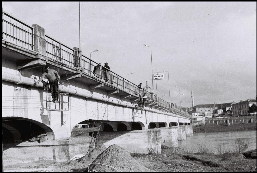
Foto 19. Köprü sadece iki yakayı kavuşturmakla kalmamış iki yaka arasında su ve elektrik gibi altyapı bağlantılarını da birleştirmiştir (Anonim).
