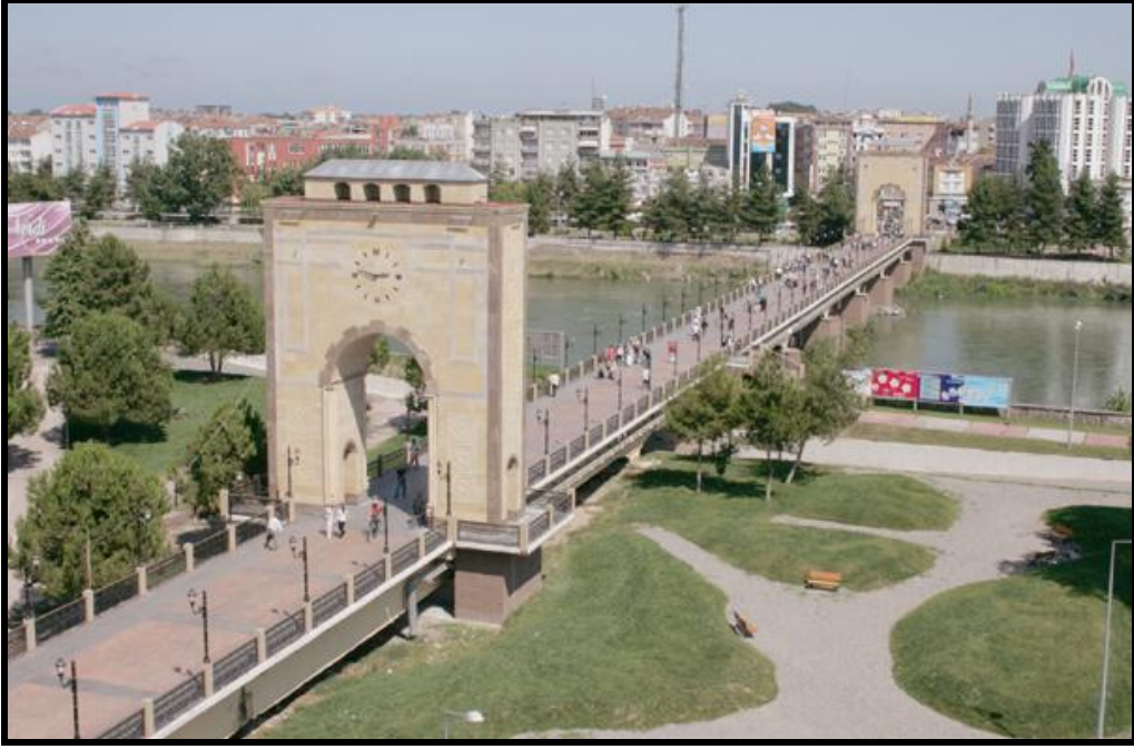
Foto 40. Günümüzde Çarşamba Köprüsü, 2013 (Anonim).
