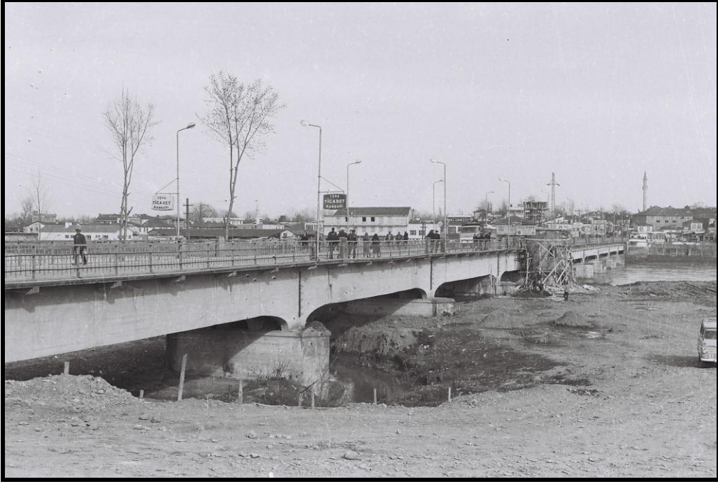
Foto 18. İki yaka birleşmiş, temelleri çevreleyen toprak malzeme temizlenmeye başlanmış (Anonim).
