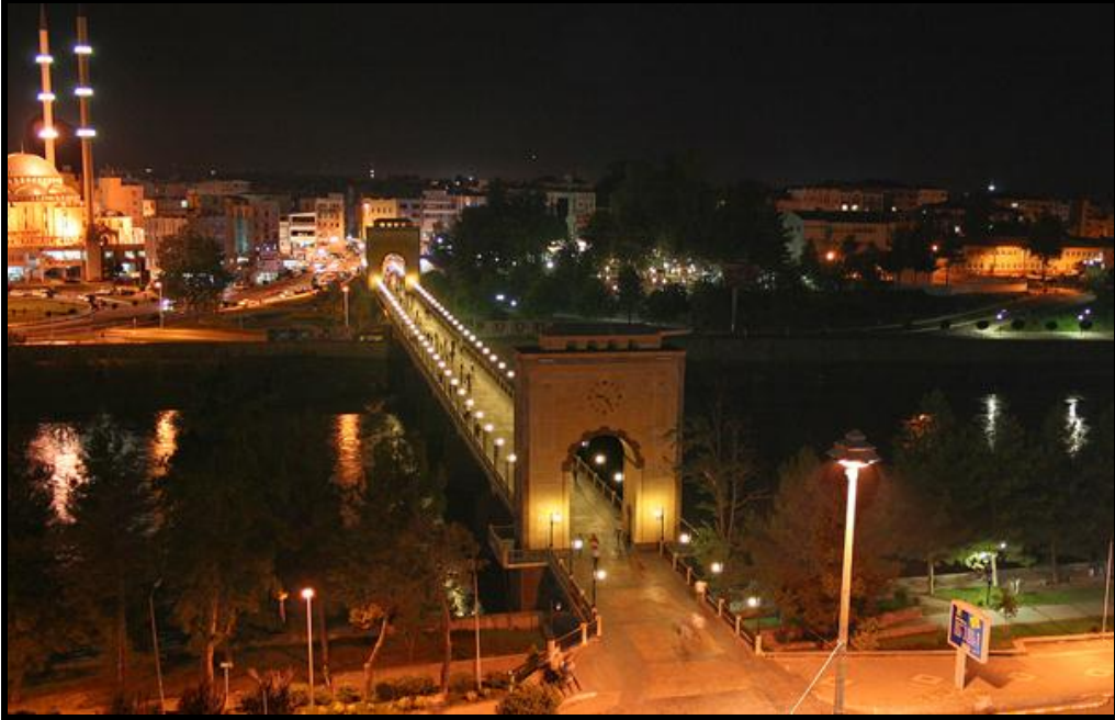
Foto 35. Çarşamba Köprüsü gece görünümü, 2012 (Çarşamba Belediye Arşivi).
