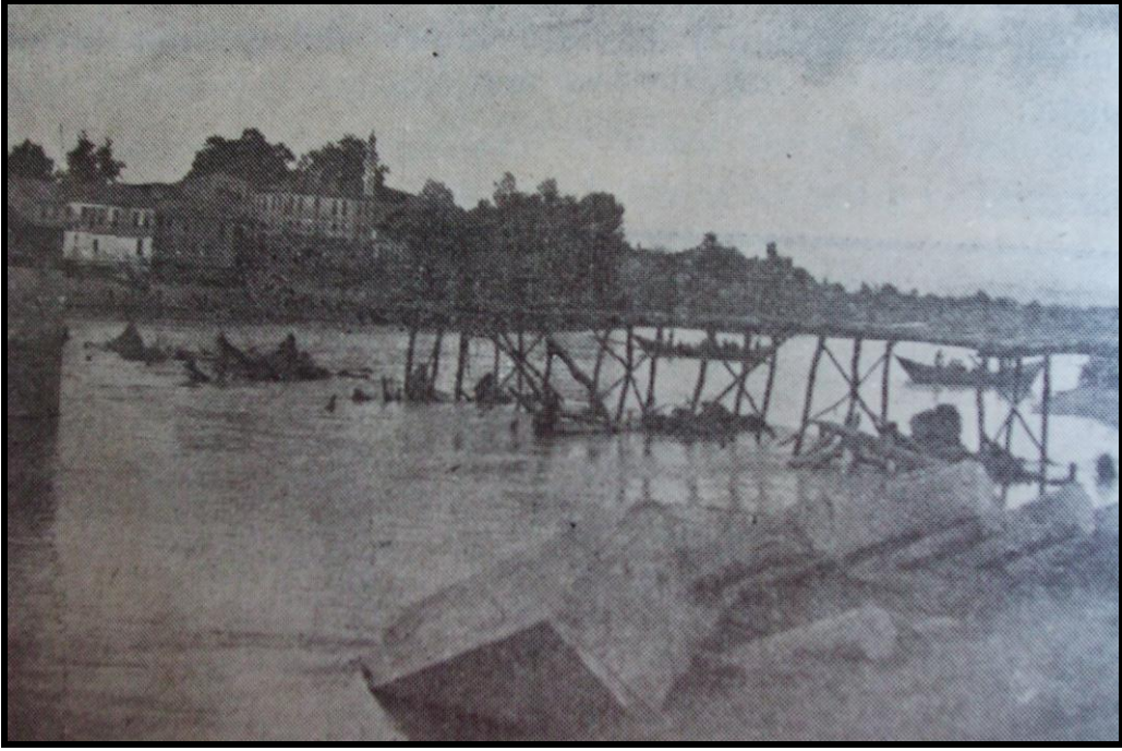
Foto 6. Başka bir selde ahşap köprü yine yıkılmış, inşa halindeki beton köprünün temelleri zarar görmüş. Arka planda kayıkla ulaşım görülüyor (Anonim).
