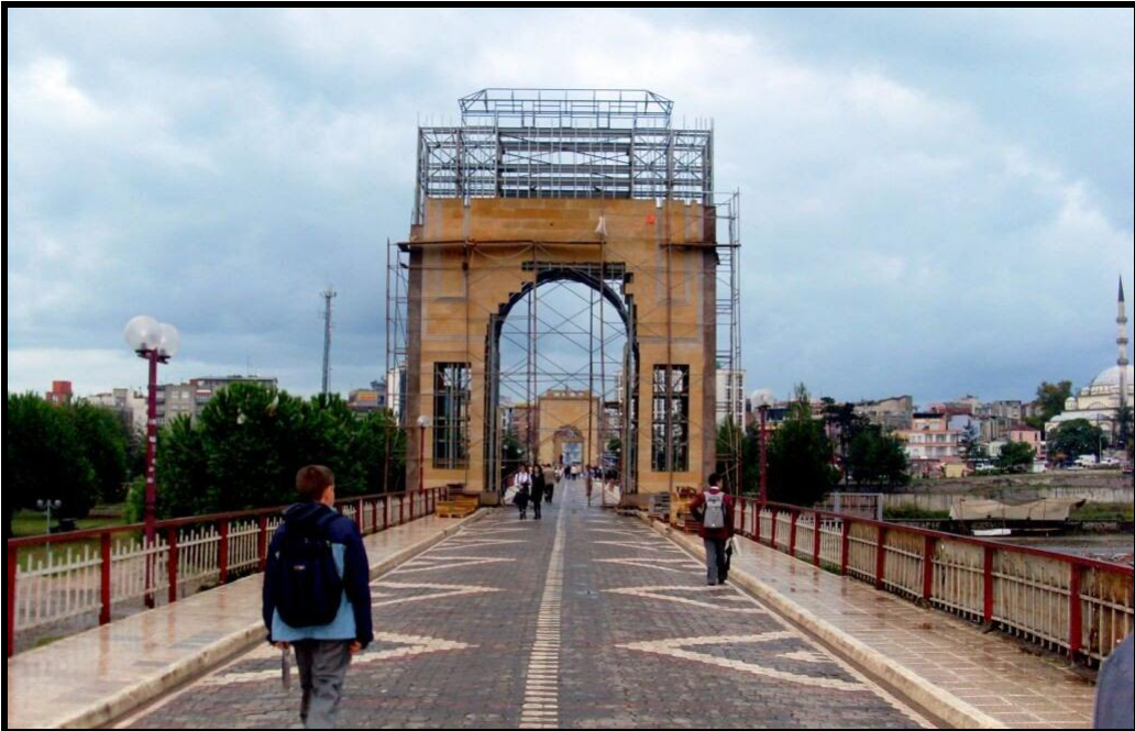
Foto 31. Köprü yayalaştırılmış, taç kapılar inşa ediliyor, 2008 (Anonim).
