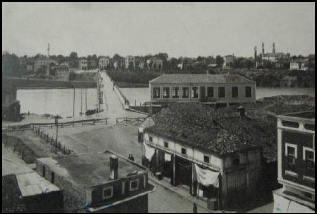
Foto 25. Beton köprü ve eski Belediye binası inşaatı (Çarşamba Belediye Arşivi'nden).
