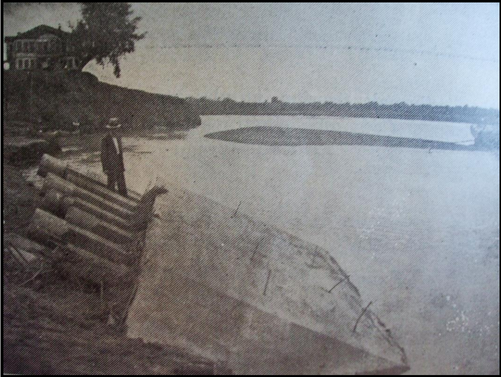
Foto 7. Selde tahrip olan henüz inşa halindeki beton köprü ayakları (Anonim).
