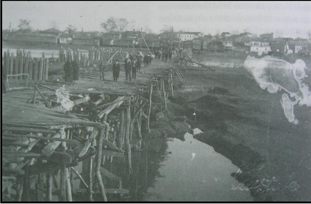
Foto 8. Tahta köprünün son demleri. Solda beton köprünün temel kafesleri görülüyor (Foto: Mustafa Tüter).
