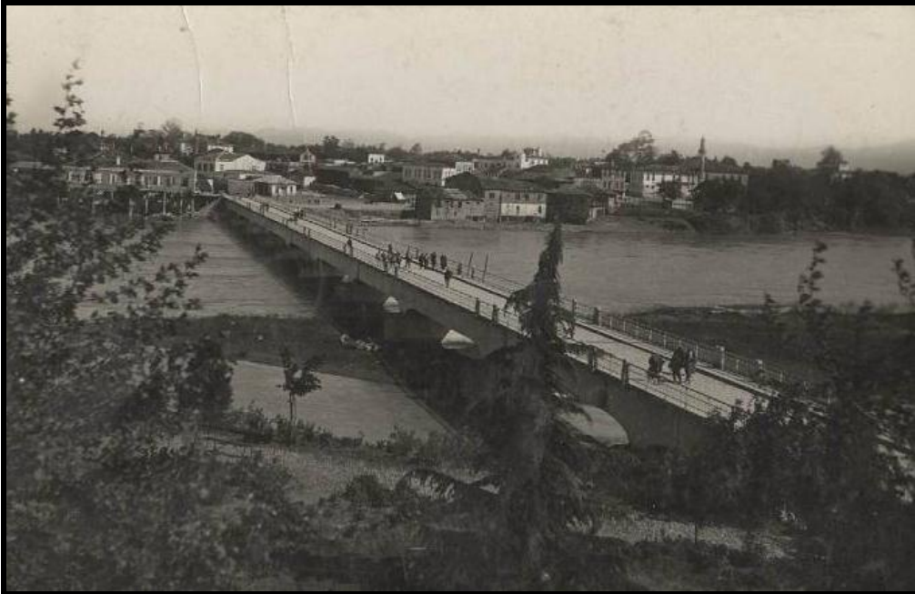
Foto 23. Beton köprü, 1950'li yıllar (Anonim).
