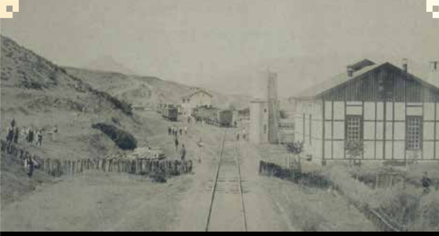
Mitroviçe Tren İstasyonu
