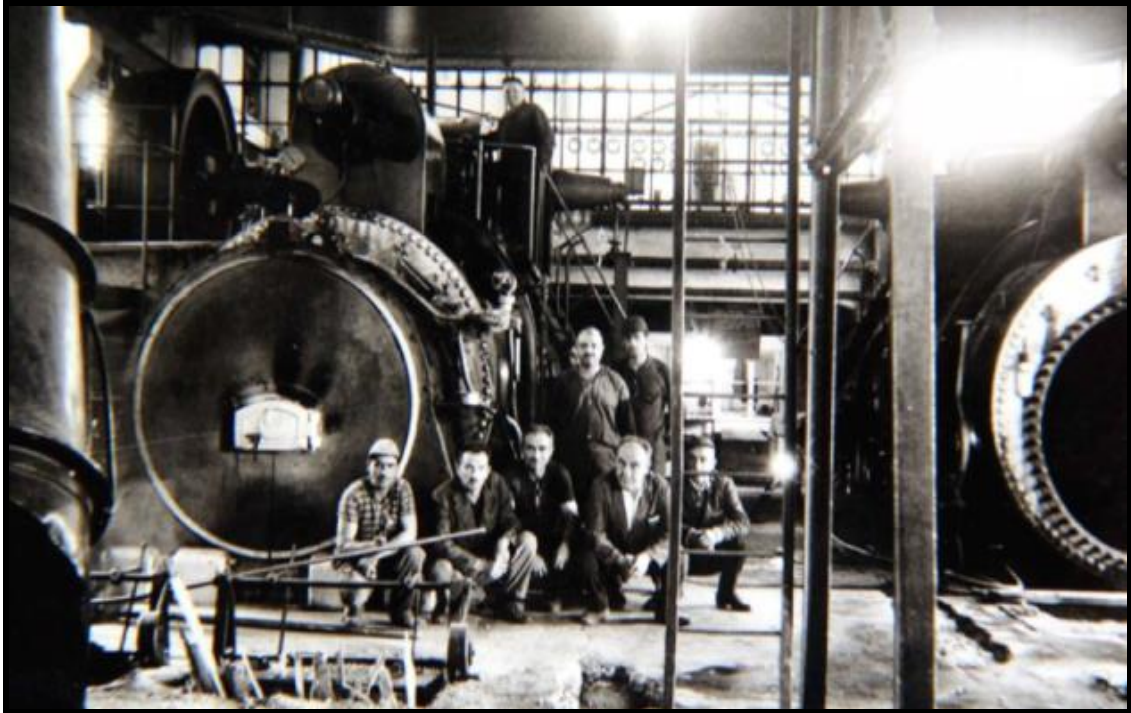
Foto 1. Fabrikada elektrik üreten jeneratör (D. Aykut YILMAZ Albümü).
