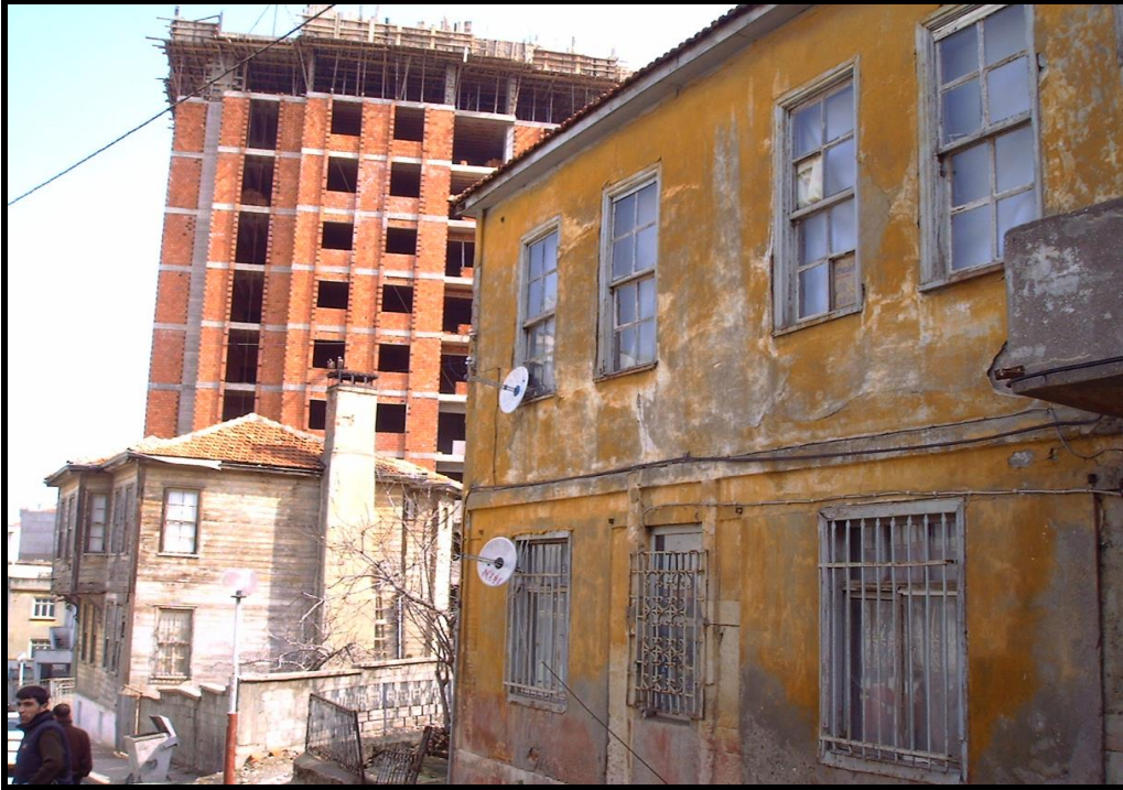
Foto 35. Apartmanlara yenik düşen eski mahalleler ve meskenler.
