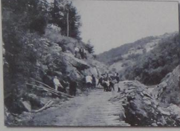
Sürütme yolu yapım çalışması
