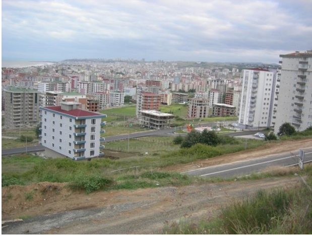
Foto 11. Atakum-Yenimahalle-İstanbul Caddesi'nden 29.8.2012'de doğuya bakış.
