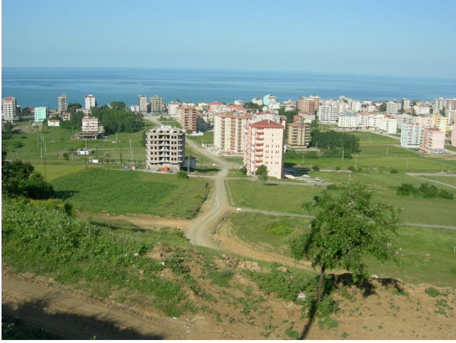
Foto 8. Atakum-Yenimahalle Vatan Caddesi'nin 1.6.2006 tarihinde görünümü (kuzeye bakış).
