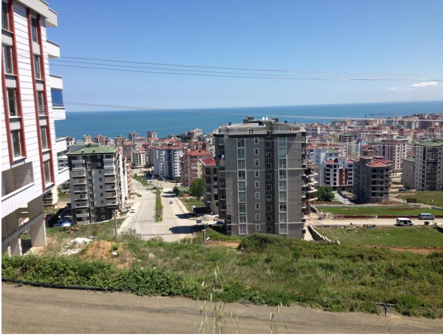
Foto 9. Atakum-Yenimahalle Vatan Caddesi'nin 1.5.2016 tarihinde görünümü (kuzeye bakış).
