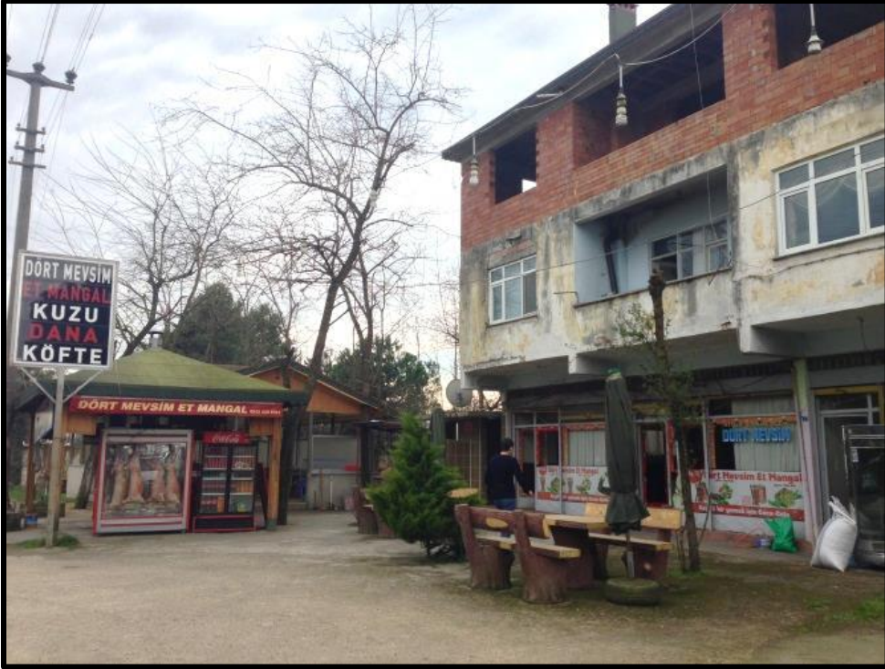
Yanlış; Aynı yerde, yolun sağ kesiminde turistik tesis (!). Binadaki çirkinlik çevredeki bütün çalışmaları gölgeliyor.
