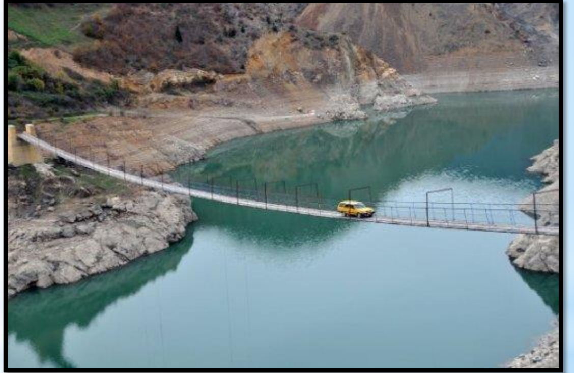
Foto 20: Ara Köyü asma köprü
