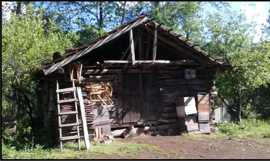
Foto 17. Ahşap kütük yığma sistemi ile inşa edilen bir samanlık (Anonim).
