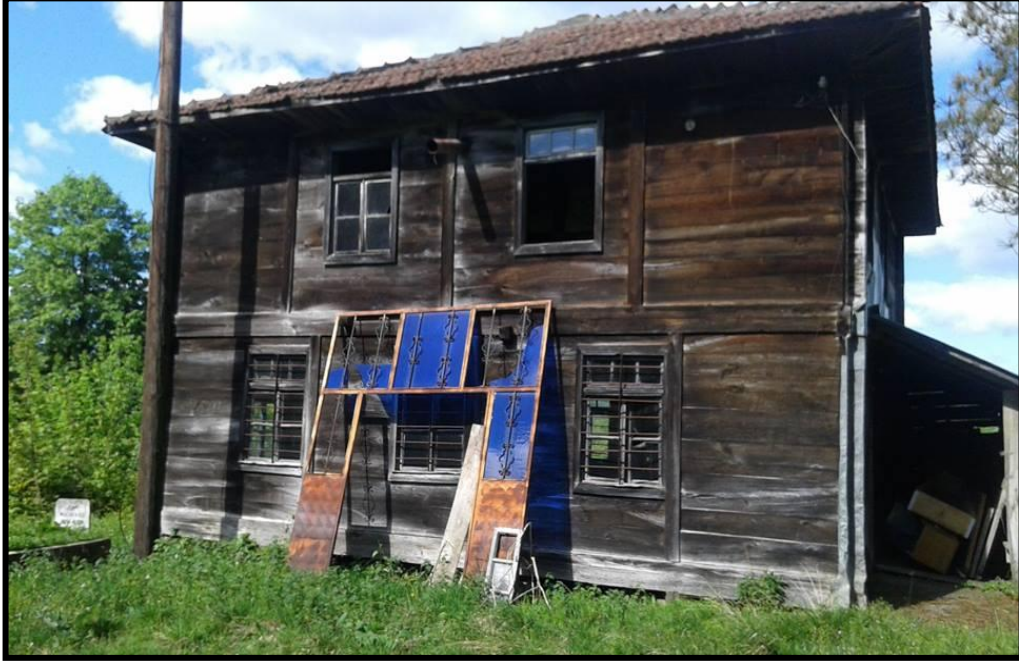
Foto 11. Tamamı ahşap yığma sistem ile inşa edilmiş meskenlerden biri.
