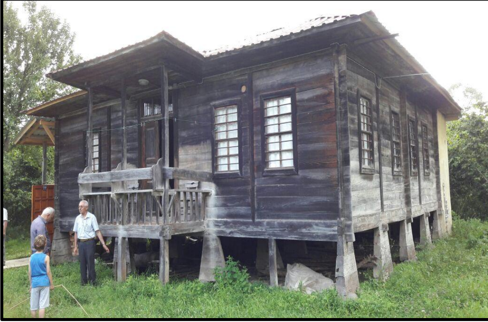
Foto 1. Evlerin tabanına koyulan taş ya da kütükler vasıtasıyla evler yükseltilerek alt kısımdan hava alması sağlanır (Foto: Mehmet Aydın).
