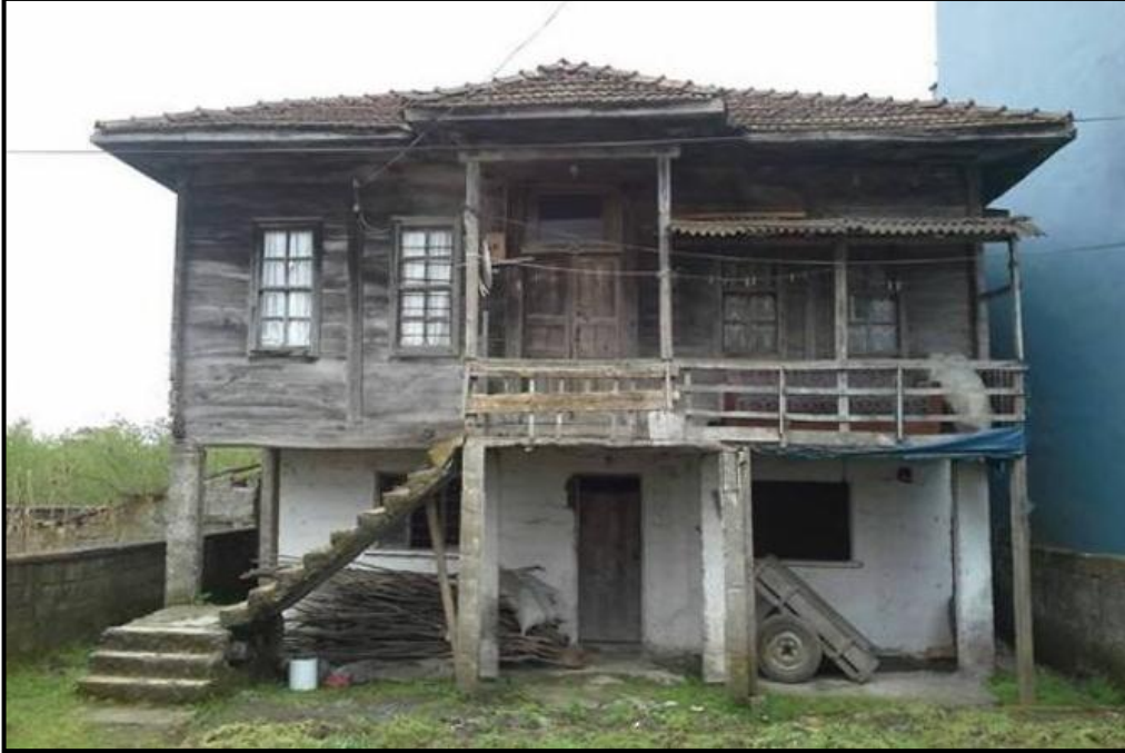
Foto 8. Alt katı briket tuğla üst katı ahşap yığma şeklinde inşa edilmiş bir ev (Anonim).
