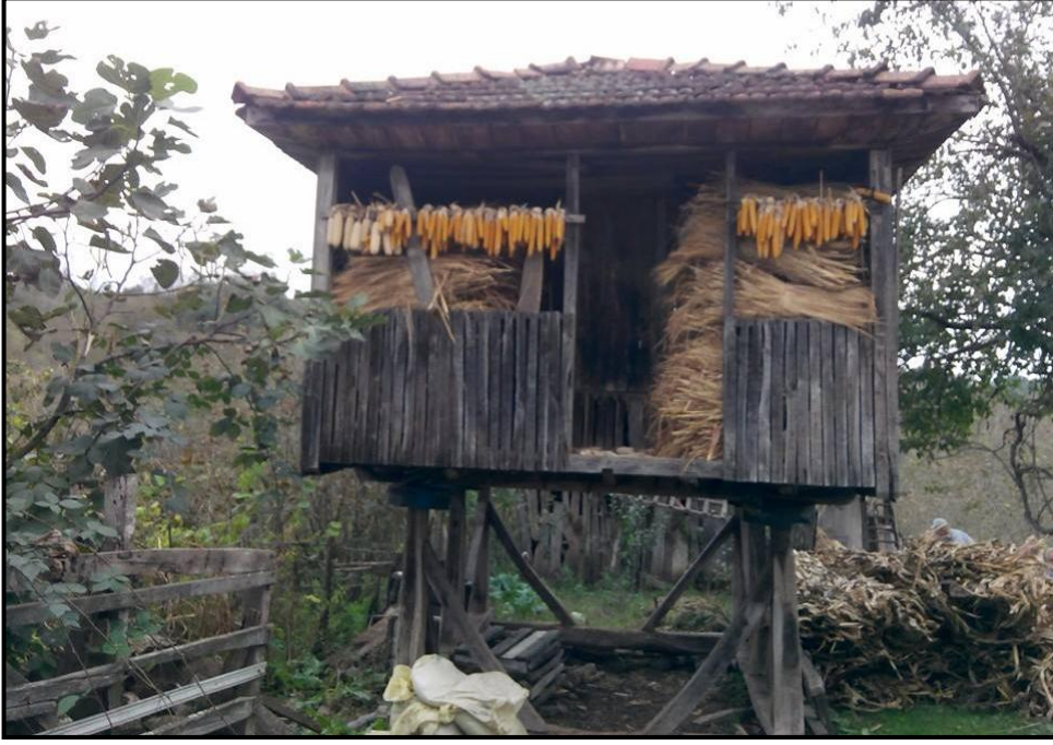
Foto 14. Serenderler yörede kışlık yiyeceklerin ve özellikle geçmiş dönemde en önemli gıda maddesi olan mısırın saklandığı birimlerdir. Bu sebeple ayakların üst kat ile birleştiği kısma koyulan silindir şekilli taşlar vasıtasıyla farelerin bu yiyeceklere ulaşması engellenir (Anonim).
