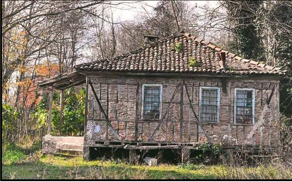
Foto 12. Ahşap karkas (iskelet), tuğla dolgu olarak inşa edilen bir mesken (Anonim).
