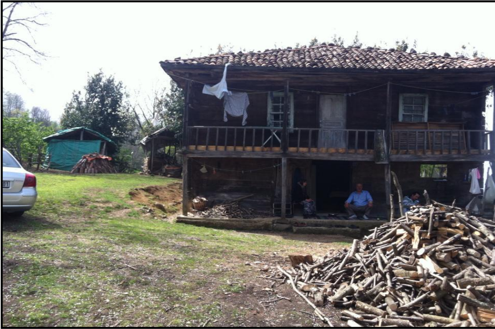
Foto 5. Evlerin ön kısmında balkonun altında oluşturulan alanda yağışlı havalarda da dinlenmek ve belirli faaliyetleri sürdürmek için yağışın etki edemeyeceği kuru alanlar oluşturulmuştur (Oğuzlu Köyü)(Anonim).
