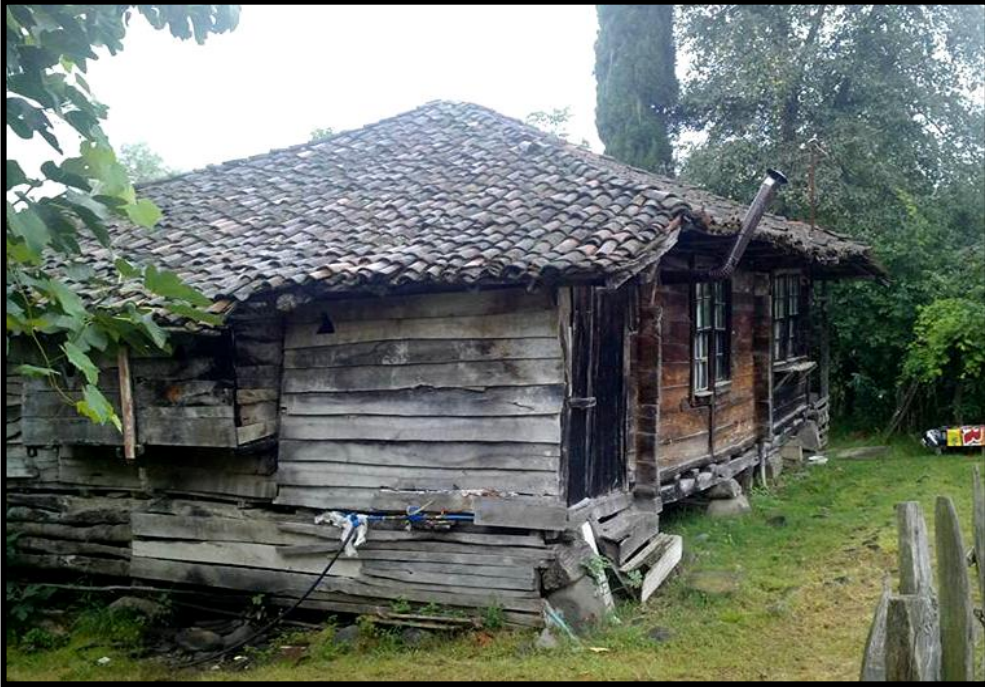
Foto 2. Evlerin tabanına koyulan taş ya da kütükler vasıtasıyla evler yükseltilerek alt kısımdan hava almasının sağlanması. Bu sistem aşırı yağışlardan sonra yer yüzeyinde su birikintileri oluştuğunda evin tabanının bundan zarar görmesini de engellemektedir (Anonim).
