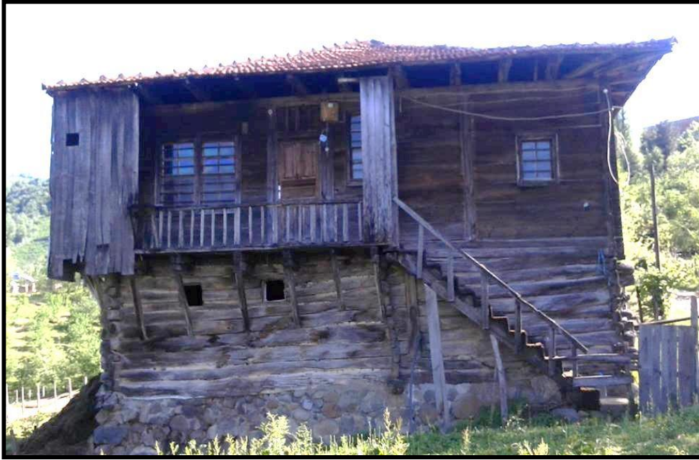
Foto 10. Tuvalet ve ahır pencerelerine sürekli hava akımı sağlayarak kokuyu engellemek amacıyla cam yerleştirilmemiştir (Anonim).
