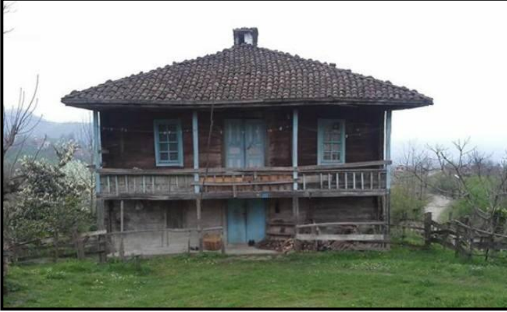
Foto 6. Çatısı dört omuz şeklinde kurulmuş ve saçakları yağmurdan korunaklı alanlar oluşturmak amaçlı uzun bırakılmış bir mesken (Anonim).
