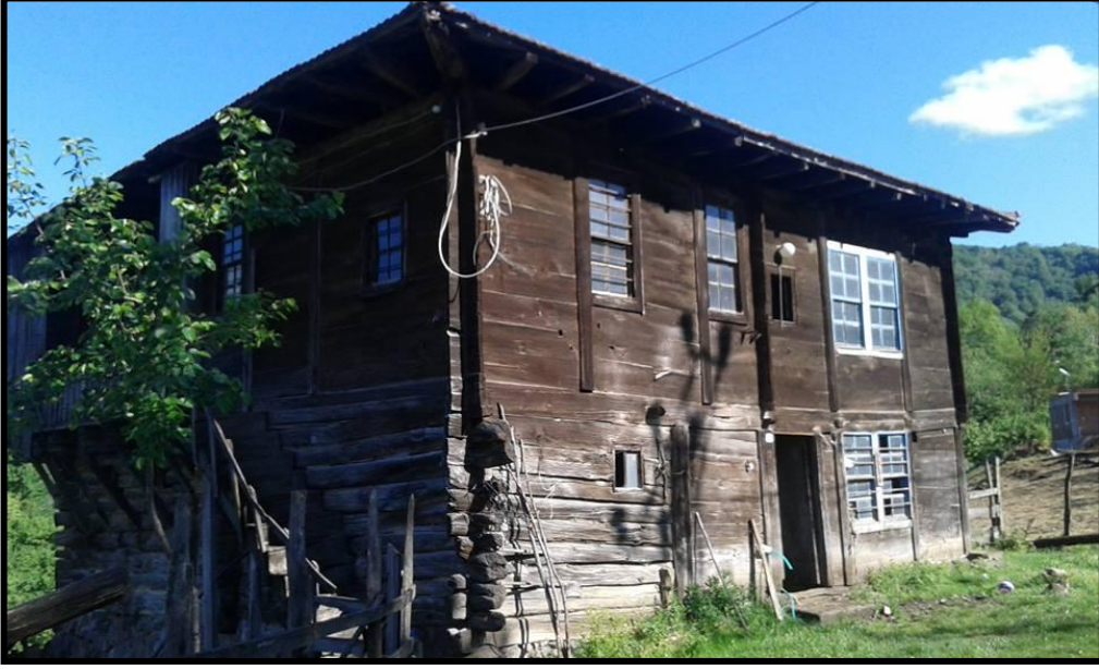
Foto 9. Ahır bölümü kütük yığma sistem ile inşa edilmiş bir ev (Anonim).
