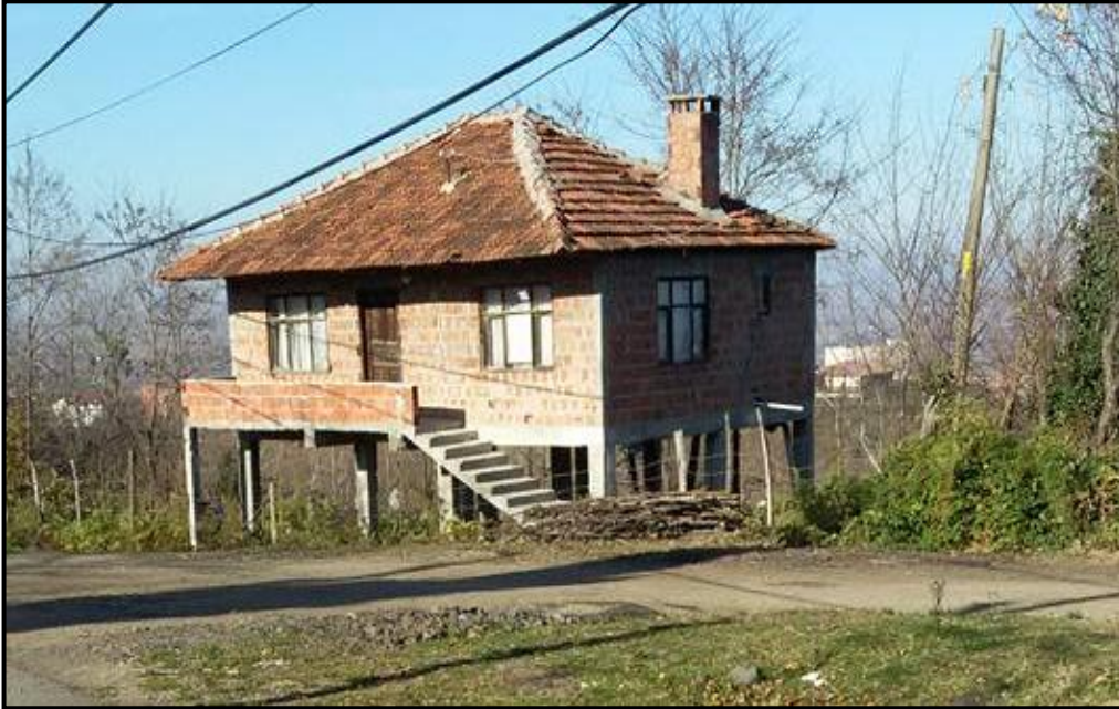
Foto 4. Bazlamaç mahallesi'nde beton kazıklar üzerine inşa edilmiş betonarme ev (Anonim).
