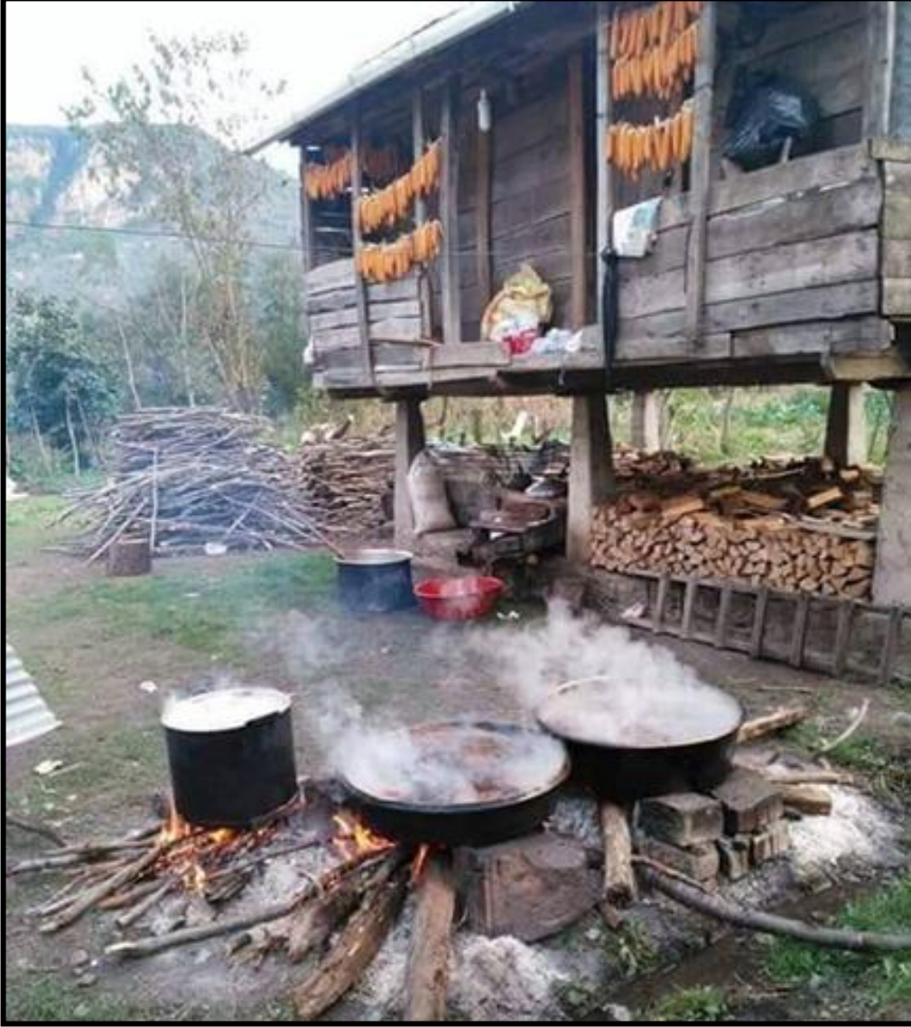
Foto 13. Serenderlerin içine yiyecek depolandığı gibi alt kısmı da odun ya da tarım araçlarının muhafazası için kullanılır. Ayrıca serenderler alt kısımlarındaki boşluk vasıtasıyla yazın sıcağın, yağışlı zamanlarda da yağıştan korunarak belirli faaliyetleri yürütme imkanı sağlar (Anonim).
