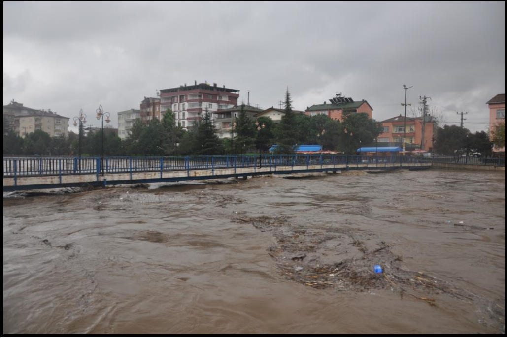
Foto 16. Yükselen sel suları yaya köprüsünü de tehdit etmiş,
