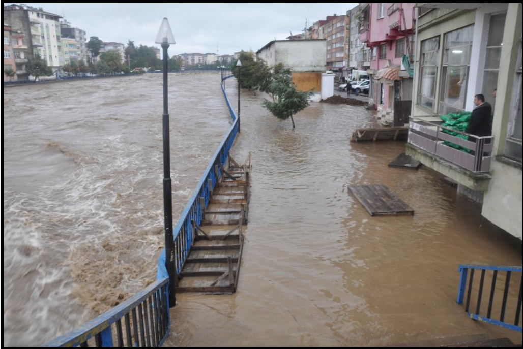
Foto 22. 21 Kasım 2014 tarihinde Terme’de yaşanan taşkın esnasında ırmağa cephesi olan konut ve işyerlerinin durumu.
