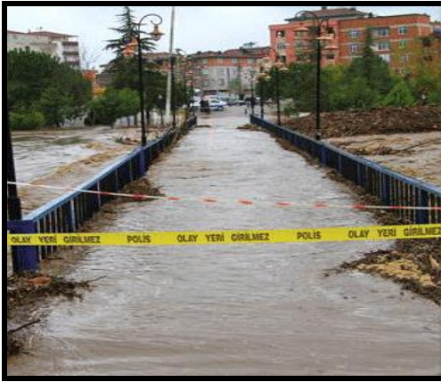
Foto 9-10-11. Terme Çayı'nın yükselmeye başlamasıyla şehrin merkezindeki yaya köprüsünün geçişlere kapatılması. Yanda görüldüğü gibi, sık sık yaşanan taşkınların yaya köprüsü seviyesinin de üstüne çıkması, her selde Belediye'yi böyle bir tedbir almaya sevketmektedir.
