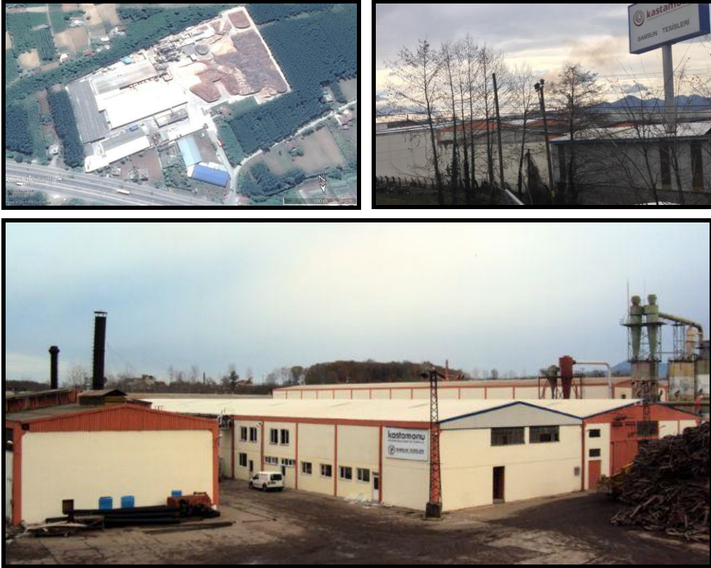
Foto 25-26-27. Terme’de Kastamonu Entegre Fabrikası kuruluş yeri (Google Earth’den) ve fabrikadan görünüm (Kaynak: Url-3).
