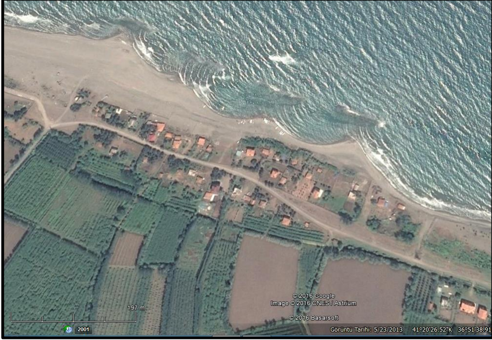
Foto 2. Sancaklı köyü sahilinde kıyı erozyonu sonucu tehlike altına giren meskenler (Google Earth'den).
