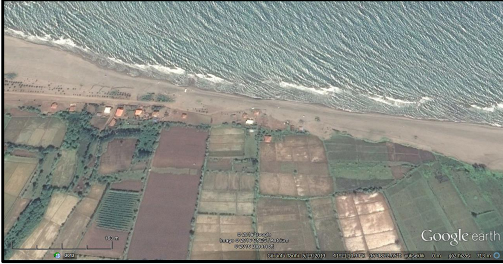
Foto 5. Taşlık köyü sahilinde kıyı erozyonu sonucu tehlike altına giren meskenler (Google Earth'den).
