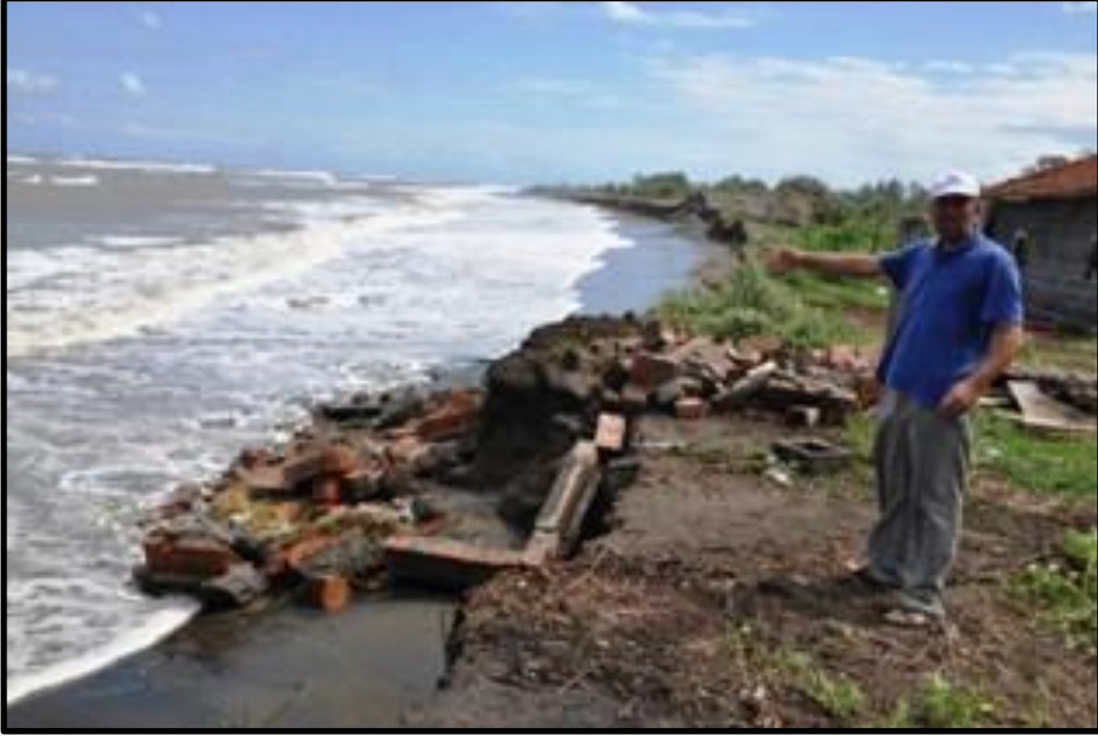
Foto 4. Sancaklı köyü sahilinde kıyı erozyonu- dalga tahribi sonucu yıkılan hayvan barınağı (Kaynak: İHA).
