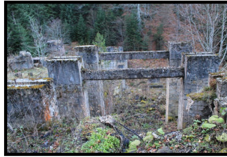
Şekil 54: Çukurçay istasyonu temel kalıntıları.
