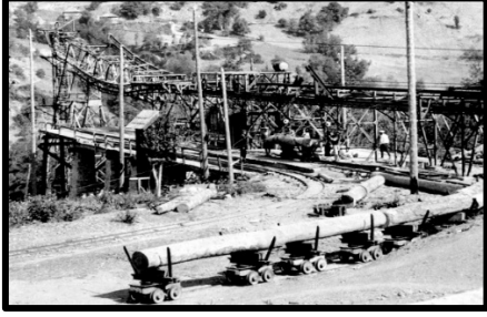
Şekil 41: Çangal bölgesinde havai hatta tomruk yüklenmesi.
