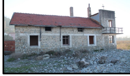
Şekil 81: Yükleme kontrol binası.
