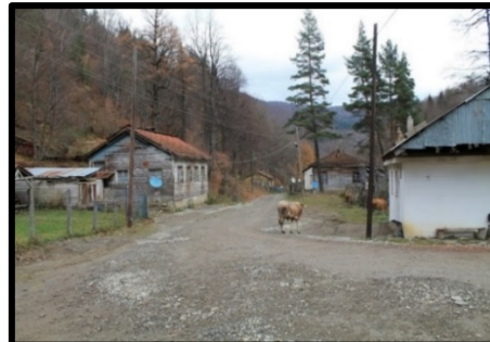
Şekil 75: Zindan bölgesinde bulunan lojmanlarda 1988 yılında meydana gelen heyelanda evleri zarar gören köylüler oturmaktadır.
