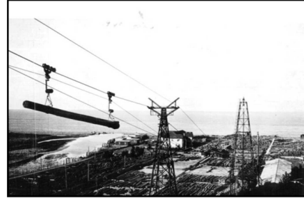
Şekil 23: Havai hat ile fabrikaya ulaşan tomruklar.
