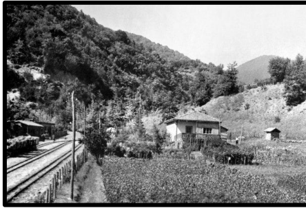
Şekil 70-71: Kazköy orman bölgesi işletme binası.
