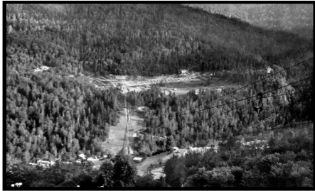
Şekil 39: 1930'lu yıllarda Çangal istasyonu.
