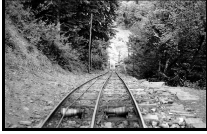
Şekil 30: Yenicealtı istasyonu vargel sistemi.
