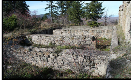
Şekil 37: Çölmektepe istasyonu lokomobilin su ihtiyacını karşılayan havuz.
