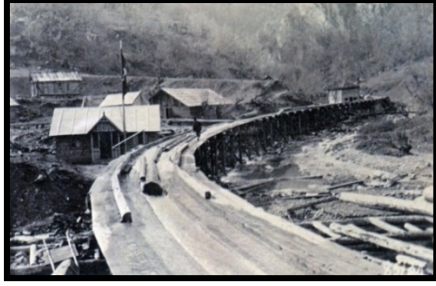
Şekil 18: Barajlarda biriktirilen tomrukların sulu oluklar üzerinden nakliyesi.
