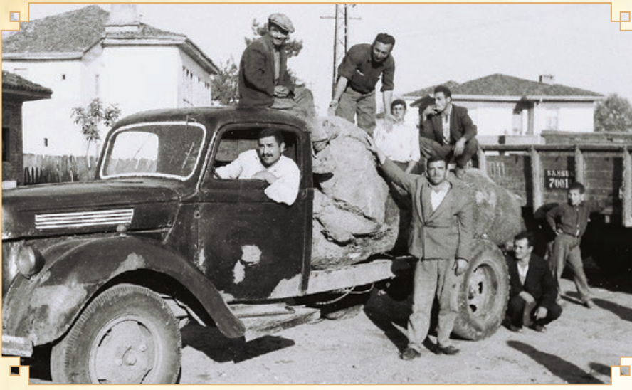
Foto 3. İnşaat zemininde kullanılan taşları taşıyan kamyon.
