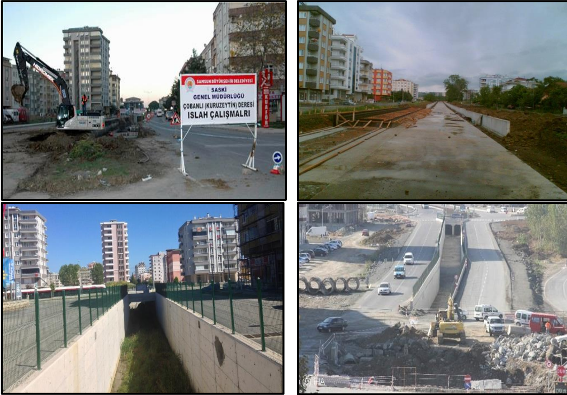
Foto 27-28-29-30. Samsun Büyükşehir Belediyesi tarafından selleri önlemek amacıyla yapılan dere ıslahı projeleri. Dereler üstleri açılarak önce görünür hale getirildi, ardından kanal içine alınarak kontrollü akış sağlandı.
