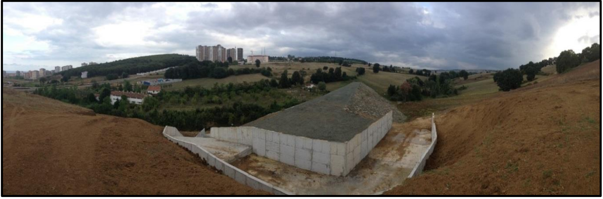
Foto 31-32. Atakum'da inşa edilen; üstte Değirmendere, altta Çobanlı sel kapanları.
