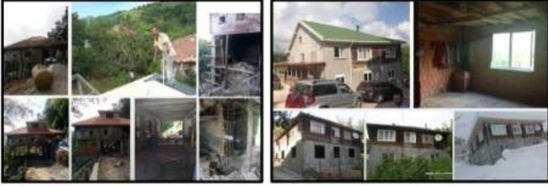
Fotoğraf 7. Sinop, Türkeli ilçesi, Taşgüneş ve Kayabaşı köylerinde eski ahşap evlerin dönüştürülmesi: Ev vinçlerle kaldırılarak alt kattan ahır çekip alınmakta, burası tuğla örülüp sıvanarak ahşap kısım tekrar oturtulmakta, alt kat beton, üst kat eski ahşap mesken olarak ev iki katlı hale gelmektedir. Son olarak çatıdaki eski taş örtünün yerine kiremit serilerek günümüz ihtiyaçlarına göre eve son şekil verilmektedir. Bu uygulama ile kırsal barınma problemi en ucuz şekilde çözüldüğü gibi, evde oda sayısı artırılarak yazın gurbetten tatile gelecek çocuklara da yer açılmaktadır.
