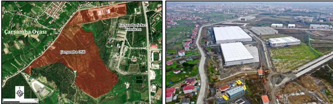
Şekil 12: Altyapı ve üstyapı çalışmaları devam eden Çarşamba OSB'nin uydu görüntüsü (Esri, 2020) (solda) ve Çarşamba OSB'ye güneybatıdan bakış (sağda) 6
