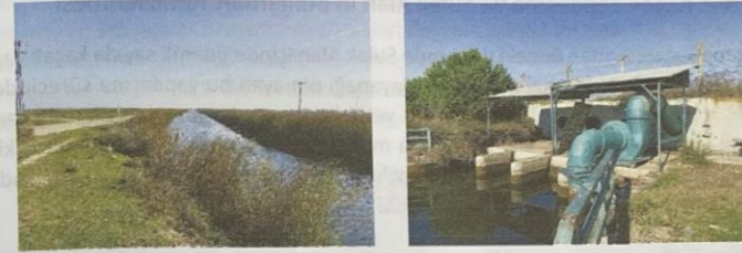
Foto 52-53. Kuşaklama Kanalı ve kanalın ucunda kirli suları denize aktaran motopompa istasyonu.
