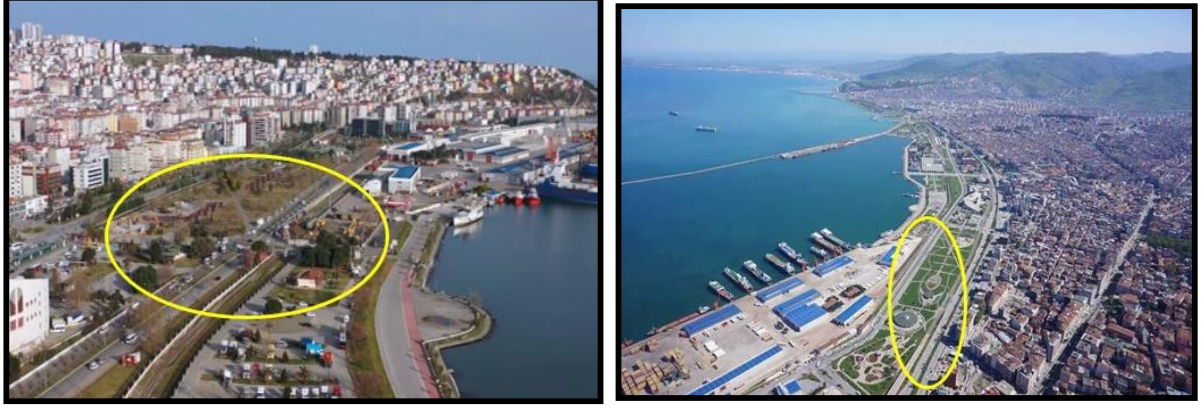
Foto 17. Liman içi dolgu alanındaki eski kamu binalarının zamanla yıkılması, bir kısmına tekrar kamu binası (Valilik ve Opera binaları gibi) yapılması, bir kısmının da yeşil alana dönüştürülmesi.
