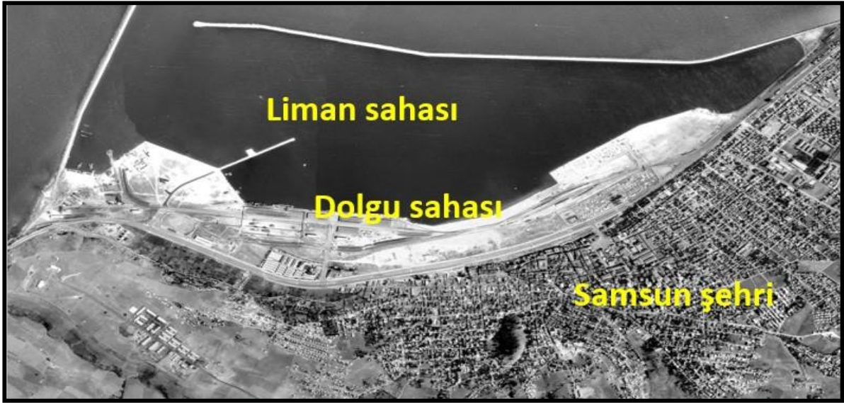
Foto 9. Ellili yılların sonları, Samsun Liman inşaatı bitmek üzere. Tanoğlu'nun 1943'te şehrin hemen önüne döşenmiş demiryoluna dikkat çeken uyarısı kaale alınmamış, yeni liman tesisleri şehrin tam önüne inşa edilerek deniz tamamen perdelenmiştir.
