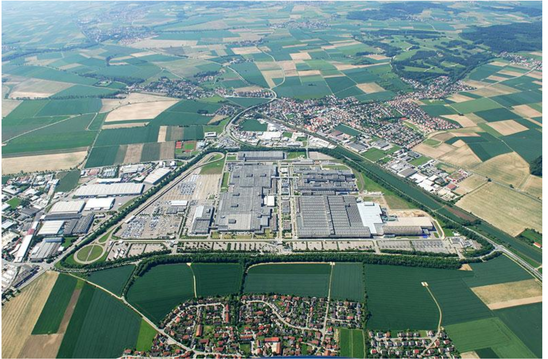
BMW Regensburg Fabrikası – Baca yok!
