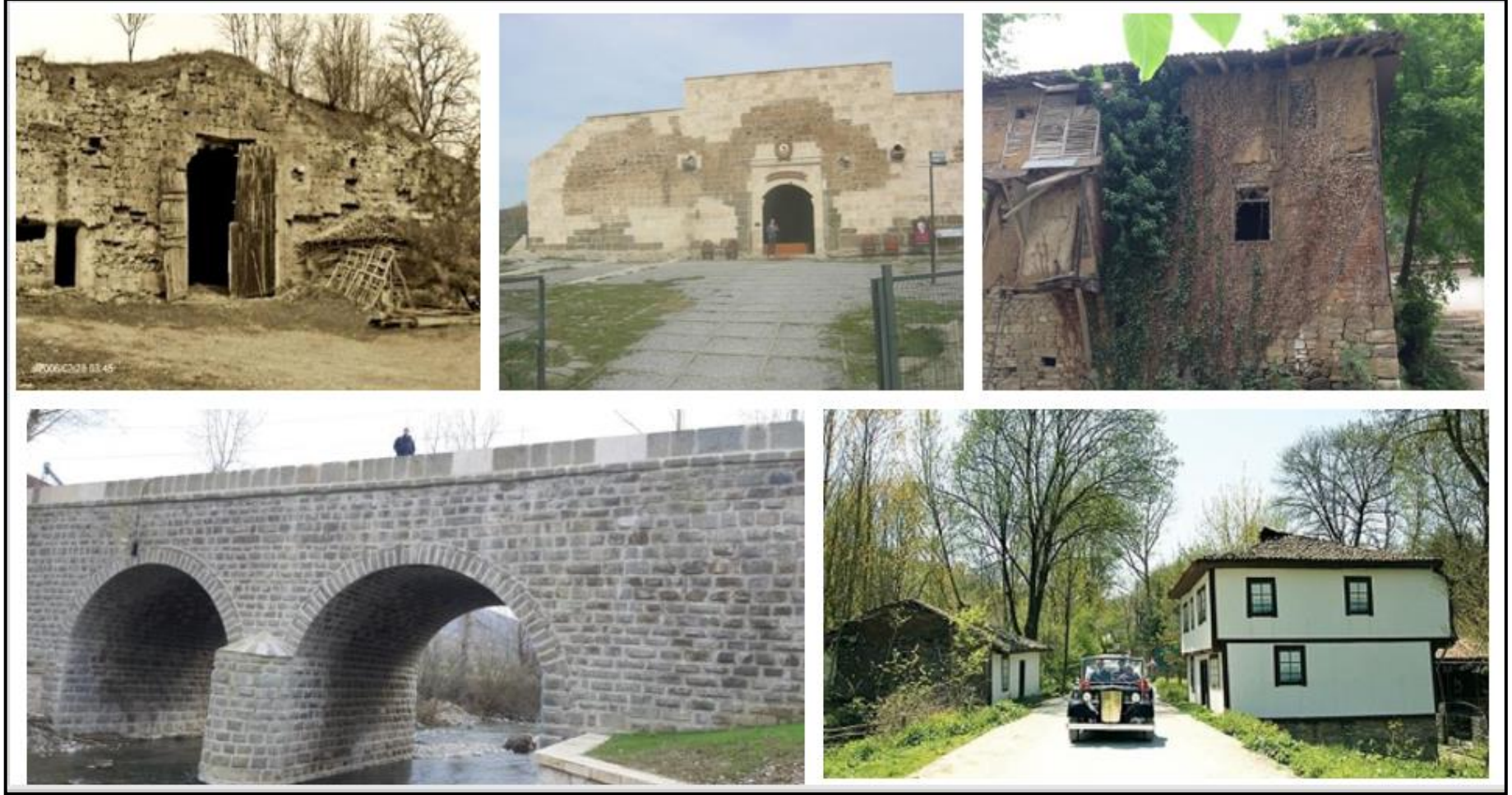
Şekil 10: Çakallı Han restore edilmeden önce harabe halindeydi. Kurtuluş Yolu projesi ile birlikte çevre düzenlemesi yapılmış, Çakallı Köprüsü tamir edilmiş, kırsal mimari örnekleri elden geçirilmiştir.
