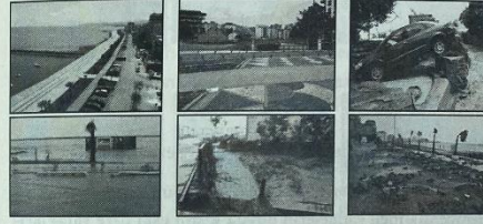
Şekil 9. Atakum - Pelitköy kavşağı. Afanlı dere. Atatürk Bulvarı'nın altından geçen suların denize ulaşmak için Adnan Menderes Bulvarı'nın (sahil araç, gezi ve bisiklet yolunun) altındaki menfezden geçmek zorunda olduğu görüntüler. Fakat bu menfez de alçak ve dar. Üstelik sel anında deniz yüzeyi ile deredeki su yüzeyi eşitlenmiş ve suyun serbestçe daha ileri gitme şansı yok. Kabaran sular dere kenarındaki araçları da yerden kesmiş.
