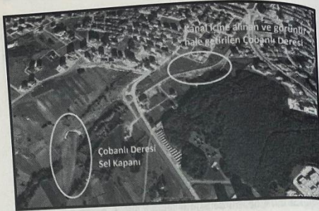
Şekil 28. (Google Earth üzerinden) Atakum-Çobanlı deresi; yukarı çığırda yüzeysel akışı, orta kısımda dere üzerine inşa edilen sel kapanı, devamında şehir içine / kentsel alana giriş yapana kadar olan kısımda kanal içine alınmış hali ve son olarak yolun altından denize ulaşması (Yılmaz ve Kaya 2020).
