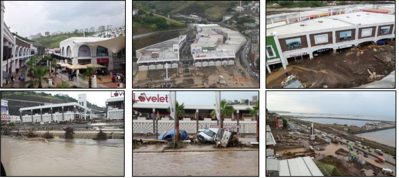
Şekil 14. 4 Temmuz 2012’de yaşanan sel felaketi AVM’nin kuruluş yerinin ne kadar yanlış olduğunu açıkça göstermiştir. AVM’nin normal açık olduğu zaman (a); sel ve sonrasındaki görünümü (b,c,d,e,f).
