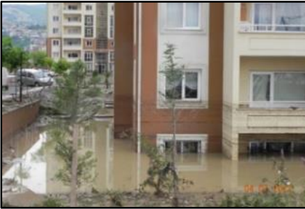
Şekil 20. Yaşanılan coğrafi çevre dikkate alınmadan inşa edilen TOKİ konutları büyük bir felaketin yaşanmasına sebep olmuştur. Olayın tek tesellisi ise; Buradan ders çıkartılarak bundan böyle zemin katlarda kapıcı dairesi olmaması yönünde imar mevzuatlarında bir değişiklik yapılması yönünde tartışmaları ülke geneline taşıyarak önemli bir sorunun gündeme gelmesini sağlamıştır.
