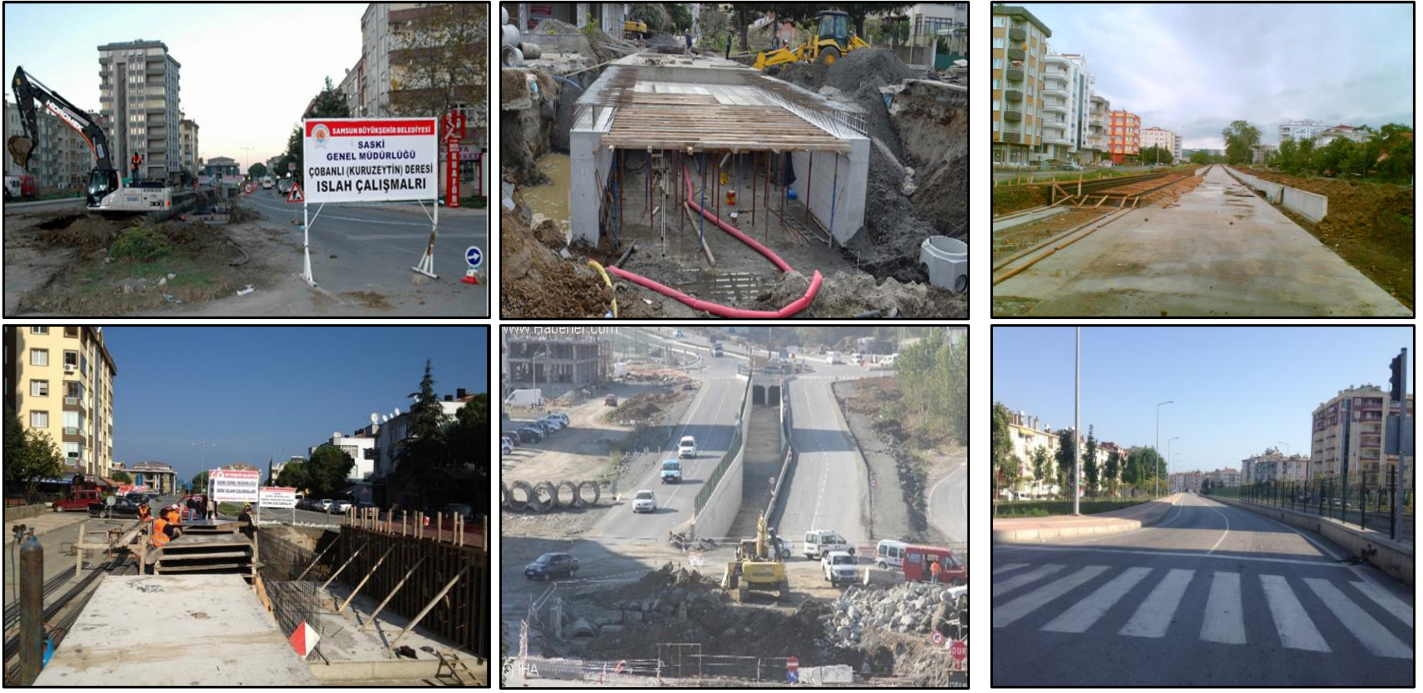
Şekil 27. Çobanlı deresinin sedde içine alınması çalışmaları (a,b,c,d,e) ve bugün (f).
