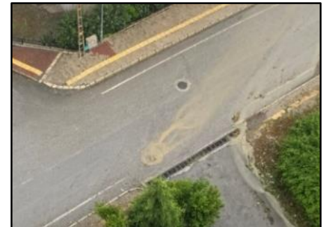
Şekil 23. a) İlkadım-Liman Mh.-Atatürk Bulvarı; sürekli temiz olması gereken mazgallar genellikle tıkalı. b) Atakum-Yenimahalle-Fatih Caddesi; mazgala gerekli eğim verilmediği için yüzeysel akışa geçen sular mazgalı aşarak cadde üzerinde yoluna devam ediyor, c) bir süre sonra yağış kesiliyor, yüzeysel akış duruyor, bu kez rögar kapaklarından sular fışkırıyor.
