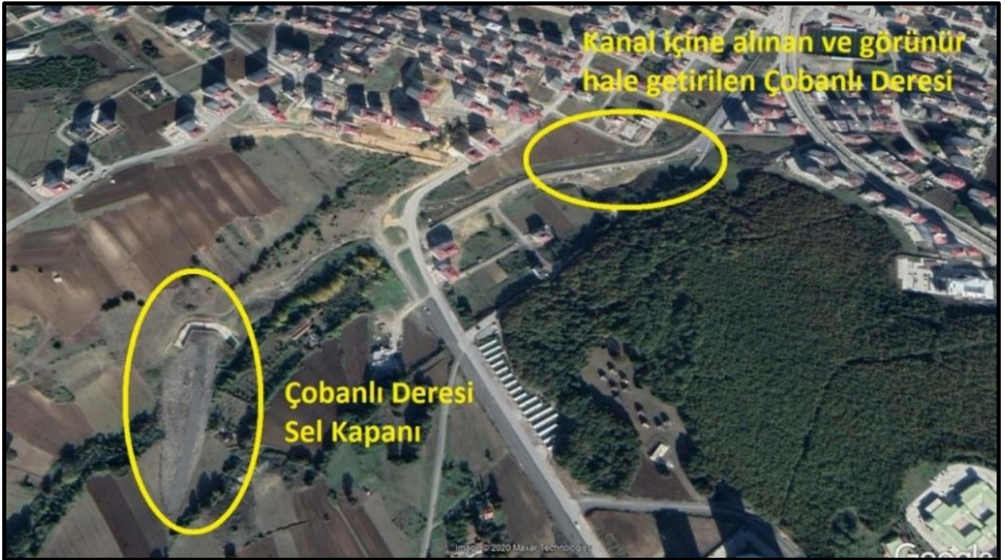
Şekil 28. (Google Earth üzerinden) Atakum-Çobanlı deresi; yukarı çığırda yüzeysel akışı, orta kısımda dere üzerine inşa edilen sel kapanı, devamında şehir içine / kentsel alana giriş yapana kadar olan kısımda kanal içine alınmış hali ve son olarak yolun altından denize ulaşması (Yılmaz ve Kaya 2020).
