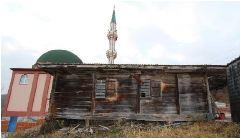
Foto. 30: Tekkeköy Yeşilalan Köyü Ahşap Camii Doğu Cephesi
