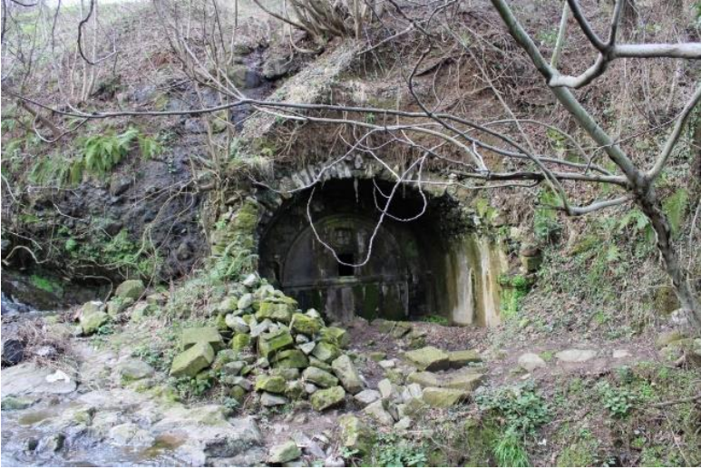
Foto. 36: Tekkeköy Çırakman Mahallesi Çeşmesi Kuzeydoğu Cephe Görünümü
