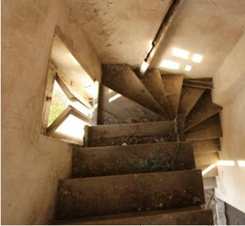
Foto. 68: Hamzalı İstasyonu Üst Kata Çıkış Merdivenleri
