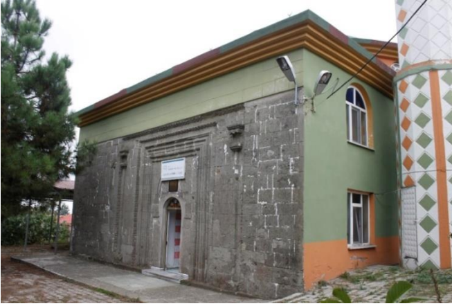
Foto. 160:  ınaralan Kilise Camii Kuzey Cephesi
