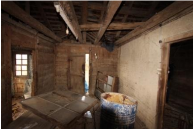
Foto. 89: Çayırçökek Köyü 1 No'lu Evin Sofası
