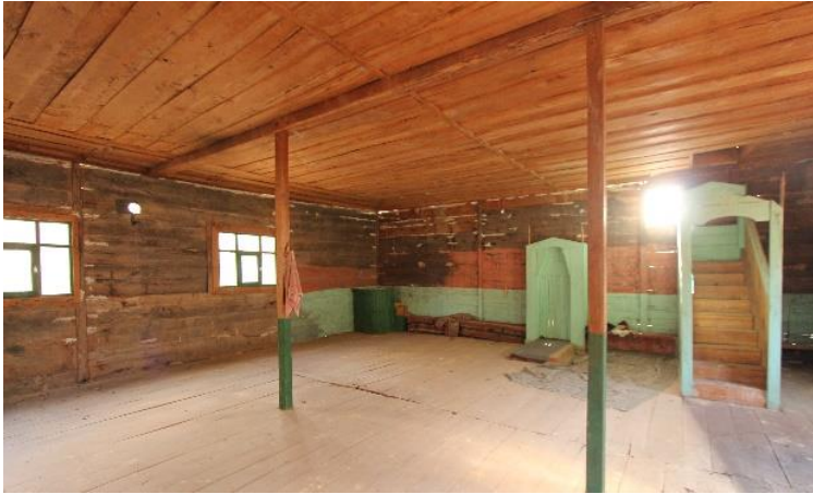
Foto. 27: Tekkeköy Yeşildere Köyü Ahşap Camii Harim Mekanı, Güney Cephe Görünümü
