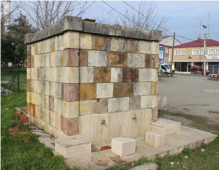
Foto. 41: Tekkeköy Büyüklü Çeşmesi Kuzey ve Batı Cephe Görünümü
