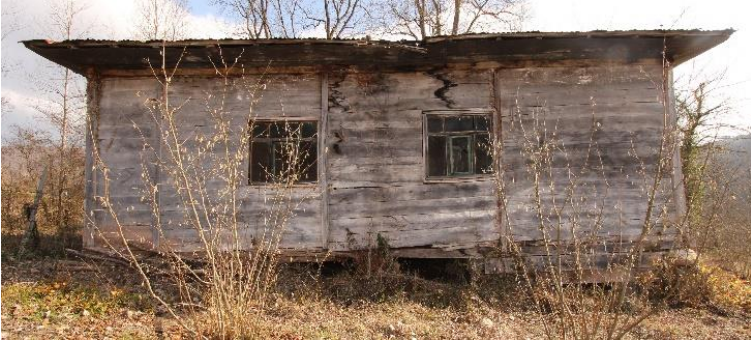
Foto. 26: Tekkeköy Yeşildere Köyü Ahşap Camii Batı Cephe Görünümü
