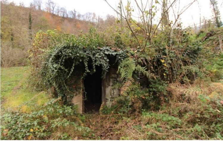
Foto. 58: Tekkek y  Sarıyurt K y  Halburcu Mahallesi Su Deęirmeni Batı Cephesi
