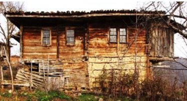
Foto. 85:  ayır  kek K y  1 No'lu Evin Yan Cephesi
