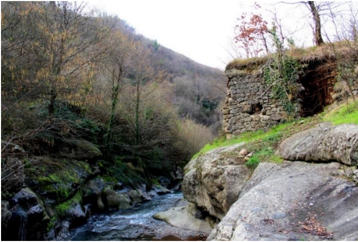
Foto. 42: Tekkeköy Değirmendere Köprüsü Genel Görünümü
