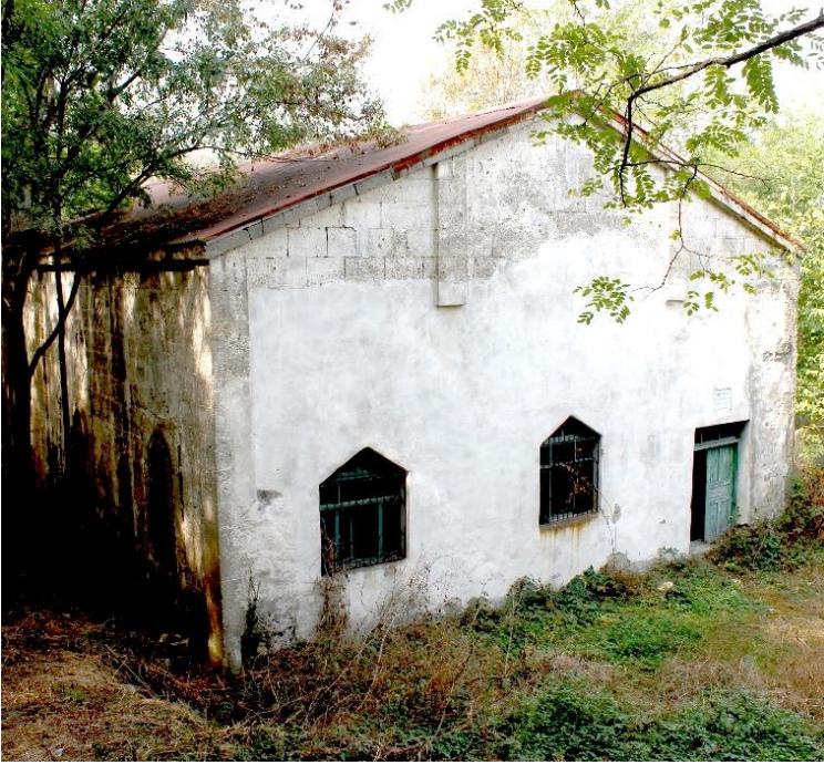
Foto. 141: Tekkeköy Antyeri (Hagios Demetrios Kilisesi) Camii Doğu Cephesi
