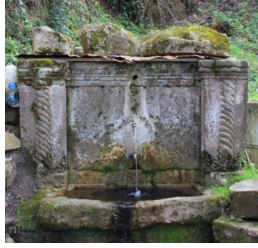
Foto. 35: Tekkeköy Fırıncıoğlu Çeşmesi Kuzeydoğu (Ön) Cephe Görünümü
