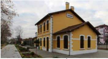
Foto. 63: Tekkek y İstasyon Binası Onarım Sonrası G r n m 
