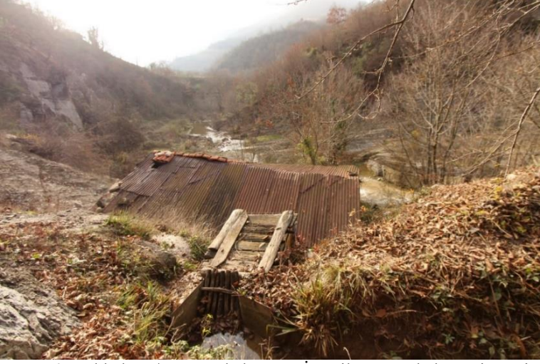
Foto. 50: Tekkeköy / Çayırçökek Köyü İsmail Çayırçökek Değirmeni Kuzey Cephesinde Su Arkı ve Ahşap Tarak
