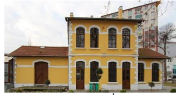
Foto. 64: Tekkek y İstasyon Binası KuzeydoĖu Cephe
