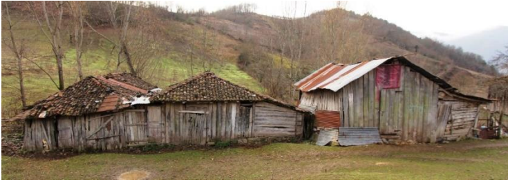
Foto. 124: Çayırçökek Köyü 1 ve 2 No'lu Samanlıklar
