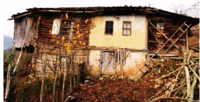
Foto. 86:  ayır  kek K y  2 No'lu Evin Yan Cephesi
