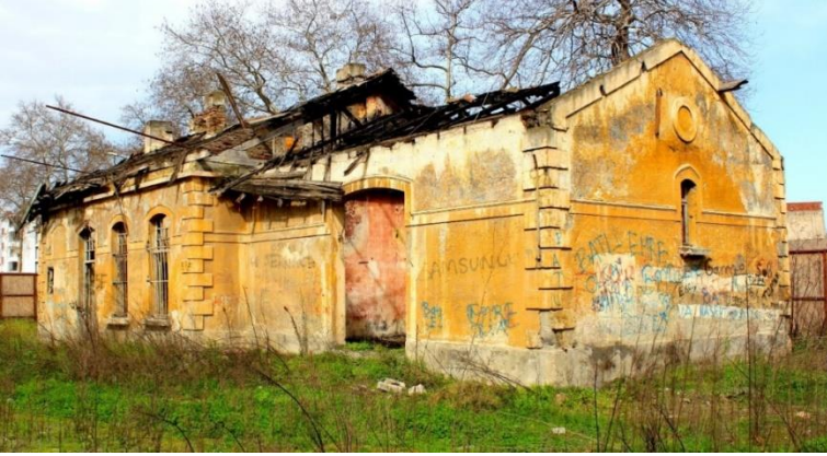
Foto. 62: Tekkek y İstasyon Binası KuzeydoĖu Cephesi 2018 Onarımı  ncesi
