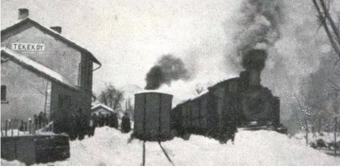
Foto. 60: Tekkeköy İstasyon Binası (Tekkeköy Belediye Arşivi)
