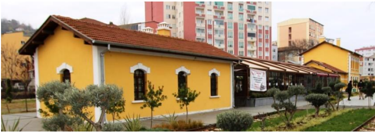
Foto. 65: Lojman ve İstasyon Binası
