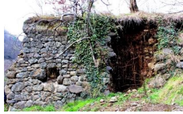
Foto. 44: Tekkek y Karaper in K y  Değirmendere K pr  Ayağı Kalıntıları
