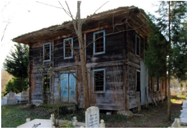
Foto. 22: Tekkeköy Güzelyurt Köyü Ahşap Camii Kuzey ve Batı Cephesi
