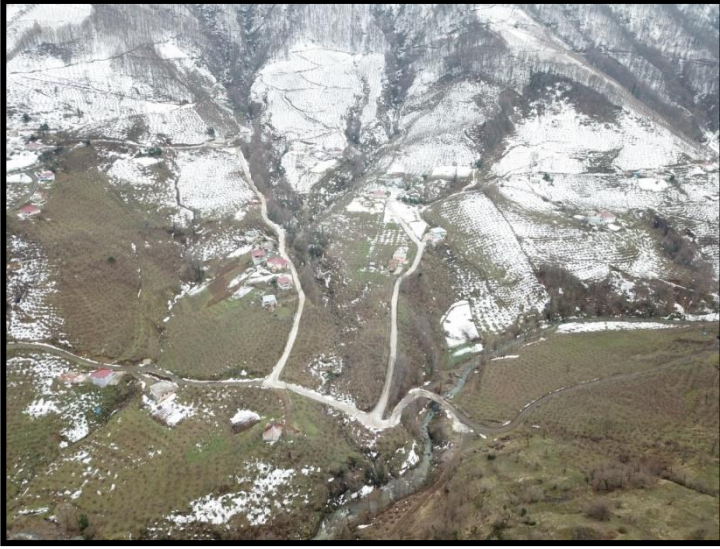
Foto 14. Seymenler'in Karşıyaka mahallesi. Yerleşme son derece dağınık olup anayolun dışında kalan ara yolların yapımı ve bakımı Tekkeköy Belediyesi sorumluluğundadır.
