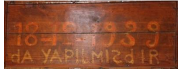
Foto. 104: Fırıncıoğlu 1939 Tarihli Mahallesi 3 No'lu Ev
