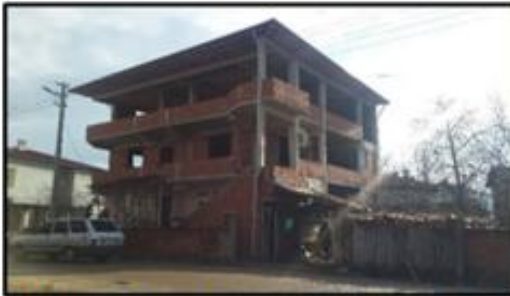
Şekil 16. Kelkit Mahallesi'nde inşaatı devam eden meskenler.
