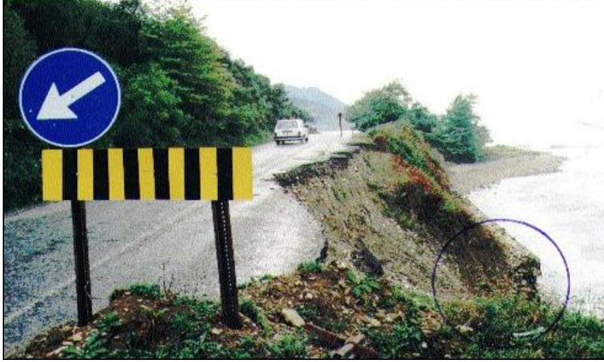
Foto 5: Türkeli - Çatalzeytin arası. Yolun kaymasını engellemek için yapılan seti dalgalar parçalamış.
