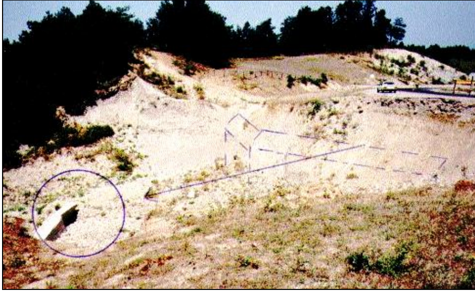
Foto 1: Sinop - Ayancık karayolunun 24. km'sindeki bu heyelan yaklaşık 300 m aşağıda bulunan deniz seviyesine kadar devam etmektedir.
