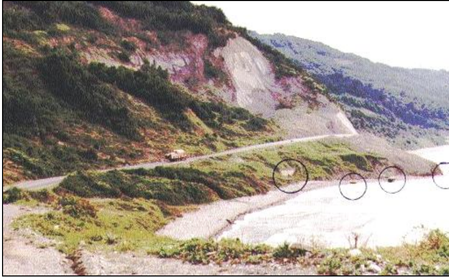
Foto 4: Türkeli - Güzelkent arası. Daire içindekiler daha önce yapılan setlerin kalıntılarıdır.
