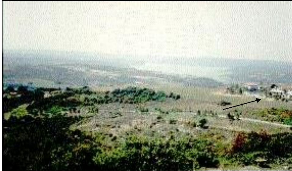
Foto 21: Durusu Park projesi konut inşaat sahasından bir görünüm. Sağda yeni yapılmış malikâne tipi bir konut.
