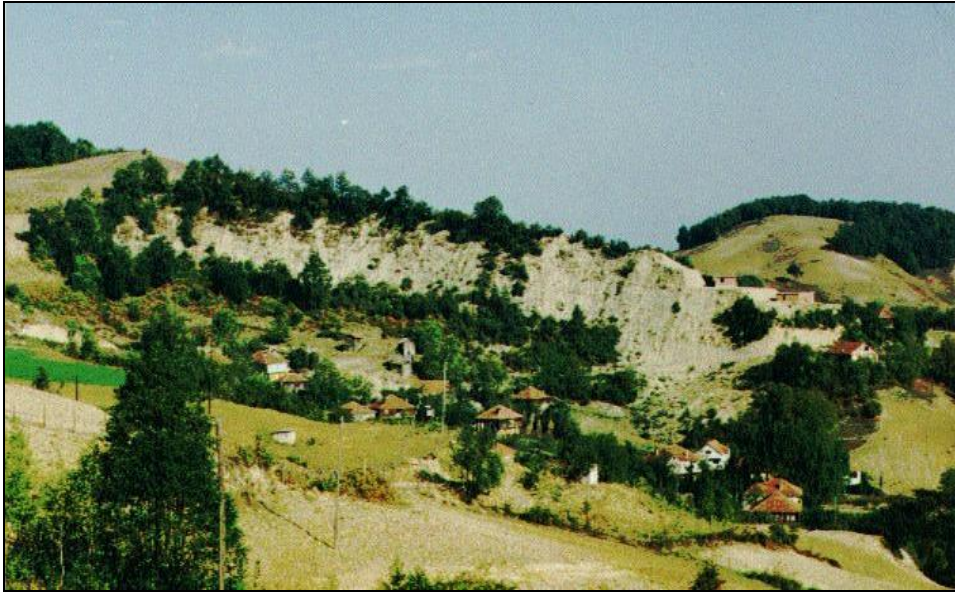
Foto 36: Kayadibi mahallesi (S'den N'e).
