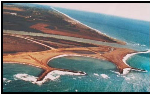
Şekil 8. a) Mahmuzlar vasıtası ile dalgaların açıkta kırılması sağlanarak kıyı erozyonunun durdurulması, b) Daha doğuya doğru inşa edilen I şekilli 4, 5, 6, 7 ve 8 no.lu mahmuzlar.
