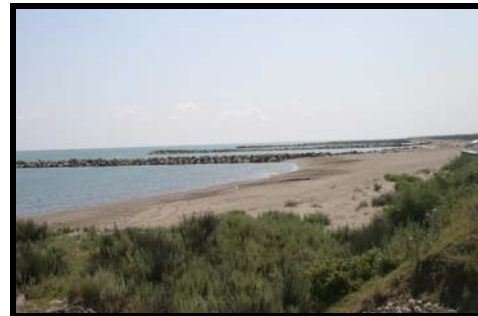
Şekil 8. a) Mahmuzlar vasıtası ile dalgaların açıkta kırılması sağlanarak kıyı erozyonunun durdurulması, b) Daha doğuya doğru inşa edilen I şekilli 4, 5, 6, 7 ve 8 no.lu mahmuzlar.
