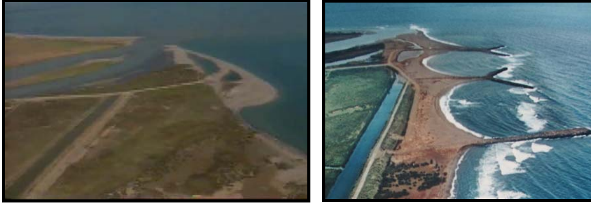
Şekil 4. Kuşaklama kanalının inşa edildiği 1990'lı yılların başlarında kanal ile deniz arasında yaklaşık 400 m mesafe vardı (a), bu mesafe 10 yılda erozyonla aşınmış ve deltadaki bu gerileme ancak mahmuzların inşası ile durdurulabilmiştir (b).
