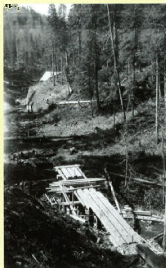
Abb. 64: Weidbahnbrücke aus Holz im Bau (F. Hahn)
