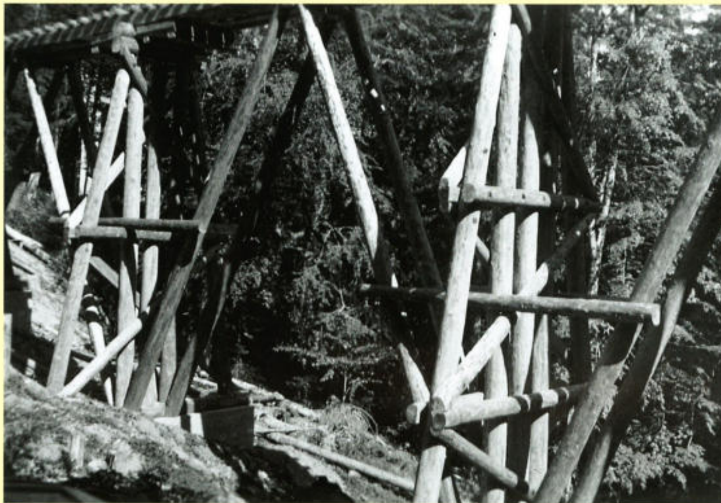
Abb. 61: Hoizellei und einfaches Sprengwerk im Detail (E. Lafont)
