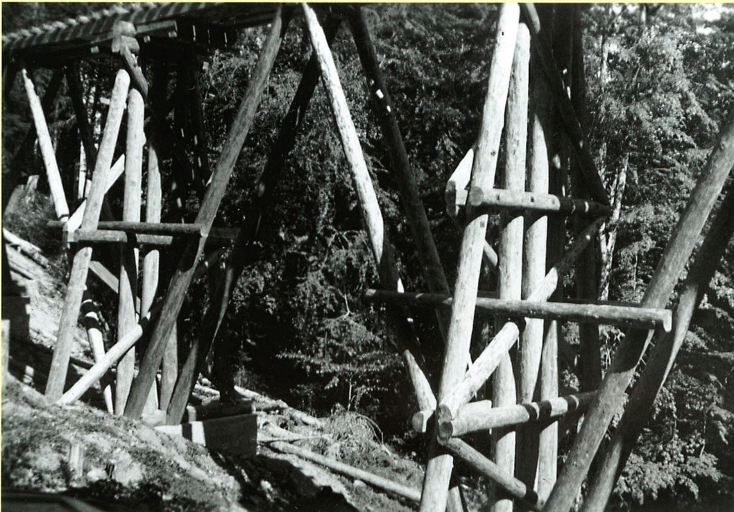
Abb. 61: Holzpfiler und einfaches Sprengwerk im Detail (F. Hafner)
