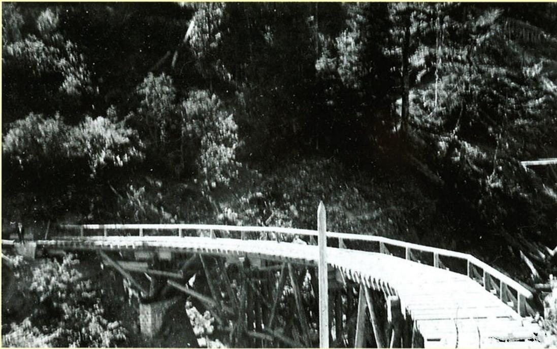
Abb. 56: Waldbahnbrücke in der Kurve ( $R = 30$  m). Gehweg und Geländer an der Außenseite der Kurve. Einfache Sprengwerke (F. Hafner)
