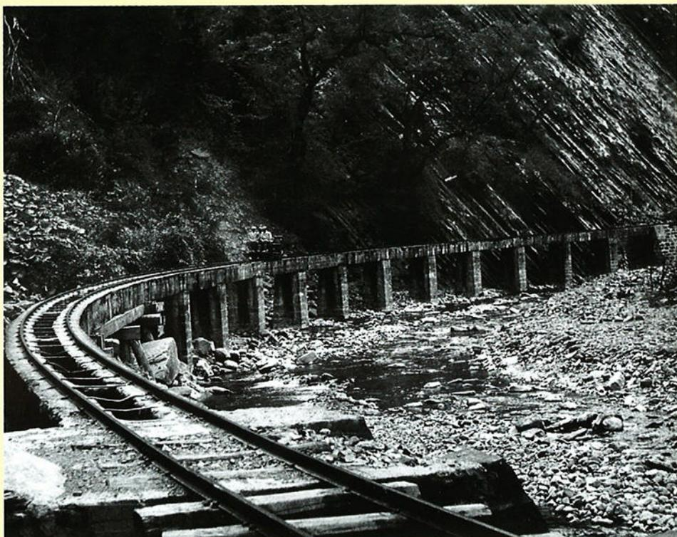
Abb. 70: Waldbahn-Hangbrücke mit gemauerten Pfeilern und Betonträgern bei der Waldbahn in Ayancik
