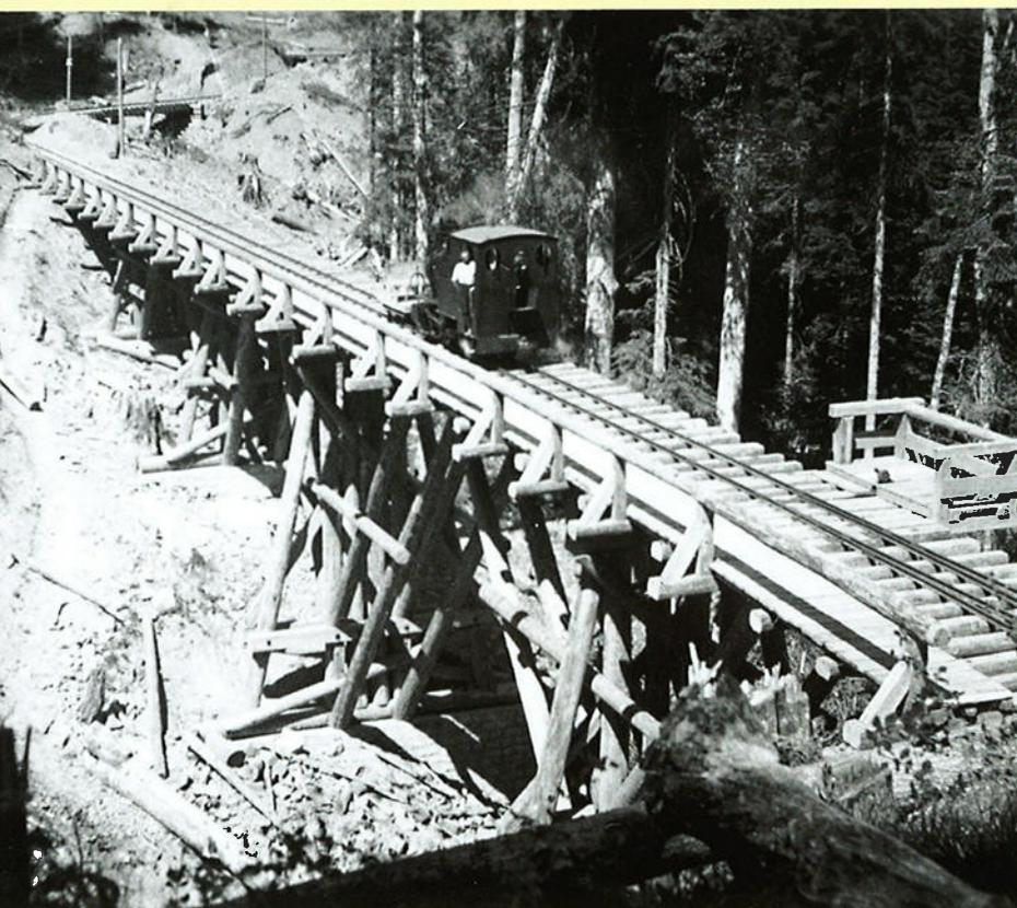
Abb. 63: Waldbahnbrücke mit einfachen und dreifachen Sprengwerken (F. Hafner)
