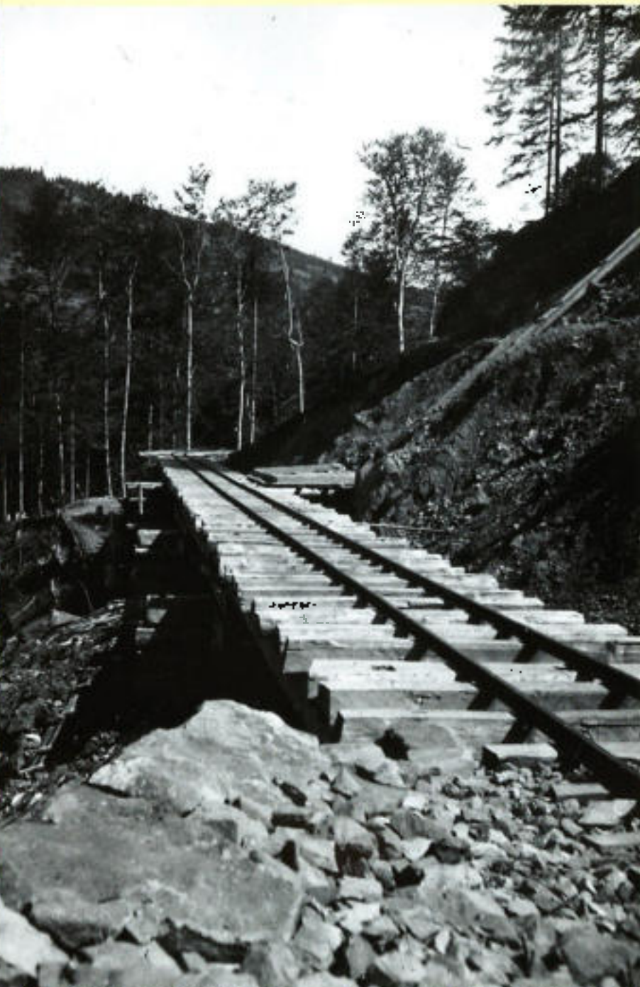
Abb. 50: Brücke auf Mauerwerkpiellern, welche auf gesundem Fels fundiert sind, über Rutschspur im Thronid (F. Hafner)
