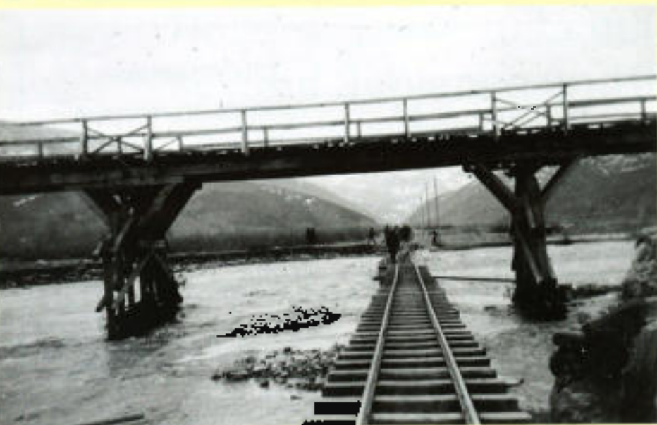
Abb. 52: Waldbahnbrücke mit zu geringer Lichterhöhe, welche durch die Ummehrung der Strecke (Spreitweite bedingt) zu (F. Hefner). Angegebene Lichterhöhe die Waldbahnbrücke, die möglichst weit so mit zur Waldbahn in Aussicht geführt, aufgrund der zu niedrigeren Bauhöhe durch Hochwasser beschädigt
