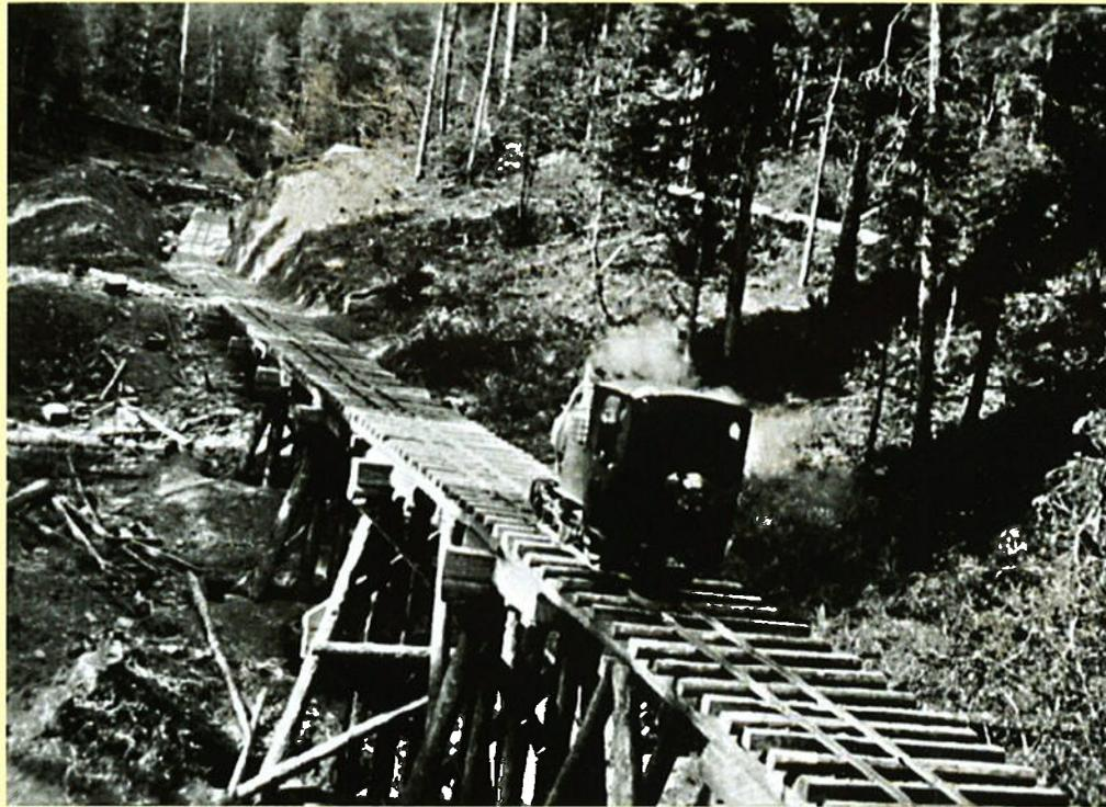
Abb. 60: Überquerung eines tief eingeschnittenen Gebirgstales mit geringer Wasserführung durch eine Waldbahnbrücke aus Holz von 10 m Höhe (F. Hafner)
