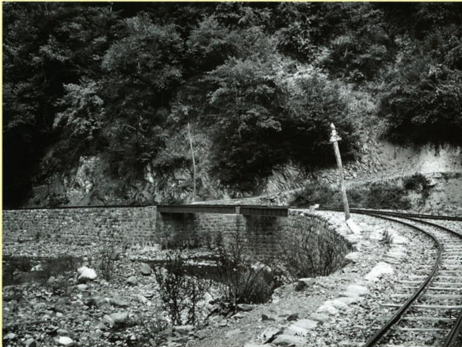
Abb. 72: Durchlass in Stahlkonstruktion auf Bruchsteinmauerwerk, rechts schließt sich vermutlich ein Gleisdreieck an.
