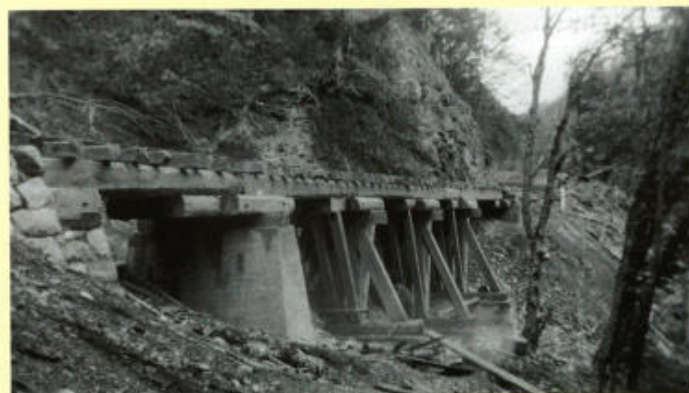
Abb. 55: Waldbahnbrücke auf Stein- und Holzpfählen (F. Hefner)
