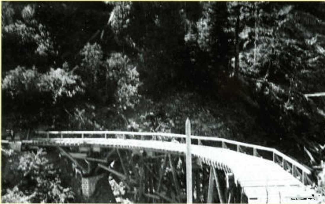
Abb. 56: Waldbahnbrücke in der Kurve ( R = 30 \text{ m} ). Gehweg und Geländer an der Außenseite der Kurve. Einfache Sperrwerke (F. Hafner)
