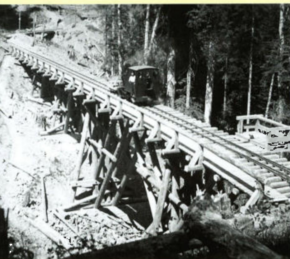
Abb. 60: Weidbahnbrücke mit ehretchen und bretelster Sprengwerk (F. Hahn)
