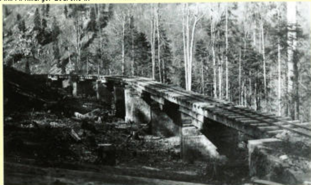
Abb. 54: Waldbahnbrücke auf Mauerwerkspfeilern (F. Hefner)
