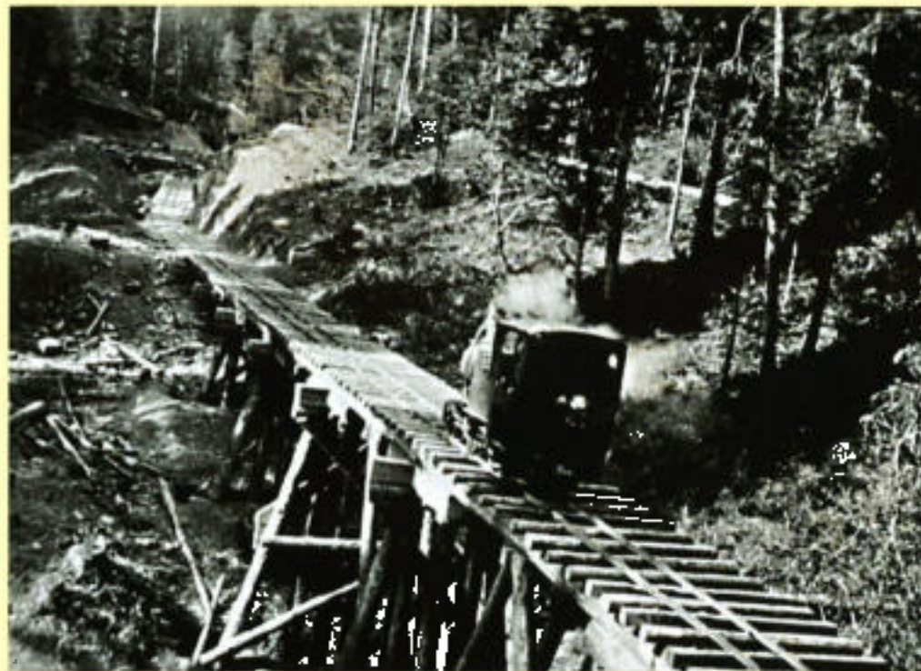
Abb. 60: Überbrückung eines tief eingeschnittenen Gebirgstals mit geringer Wasserführung durch eine Weidstrecke aus Holz von 15 m Höhe (E. Lafont)
