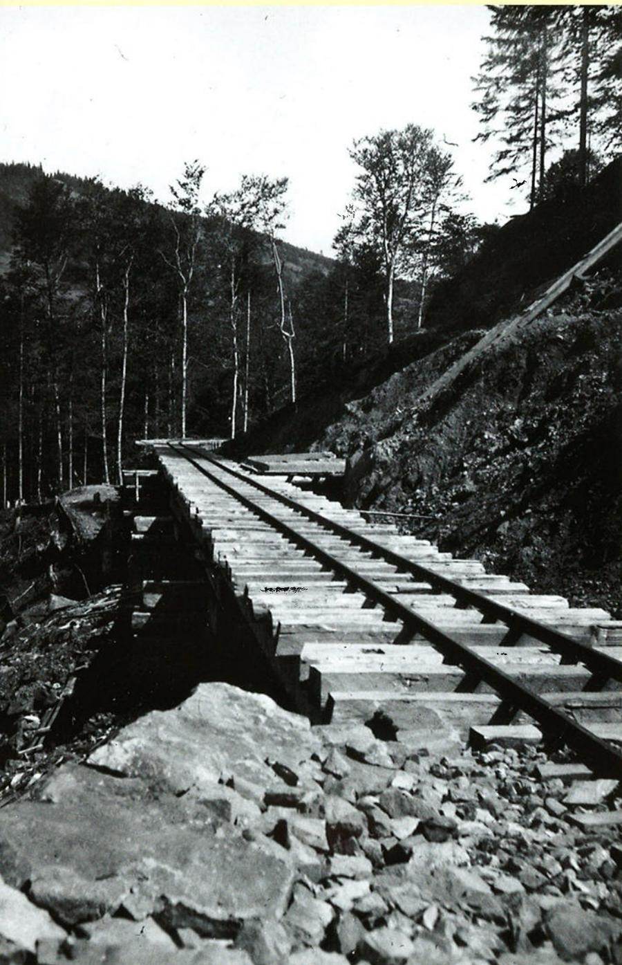
Abb. 50: Brücke auf Mauerwerk Pfeilern, welche auf gesundem Fels fundiert sind, über Rutschung führend (F. Hafner)
