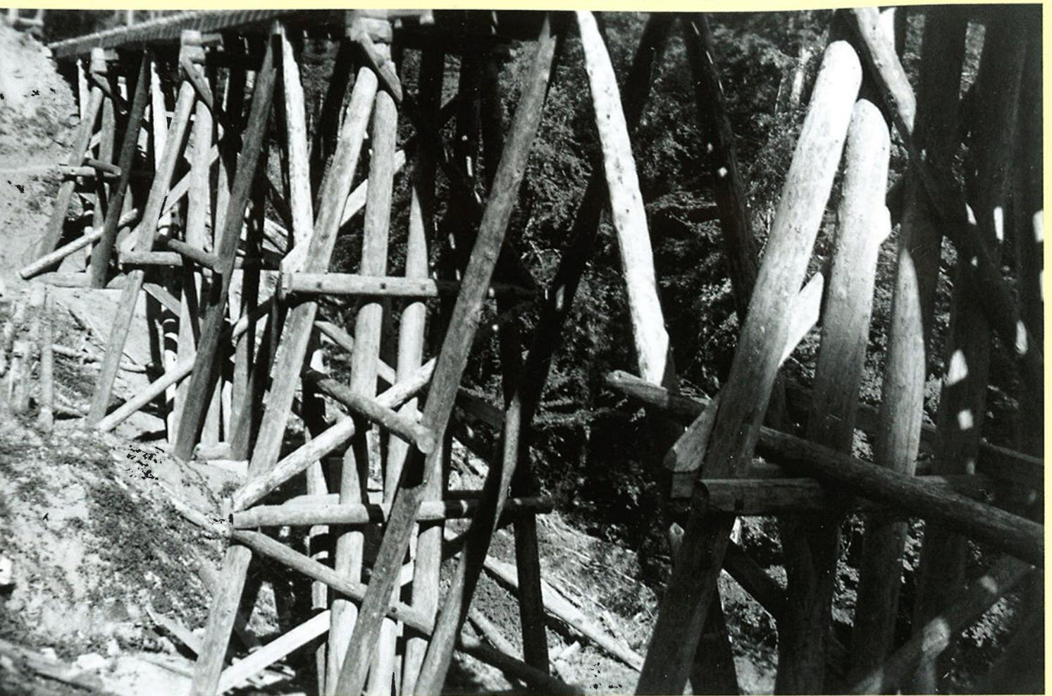
Abb. 62: Holzpfiler und einfaches Sprengwerk im Detail in einer anderen Ansicht (F. Hafner)
