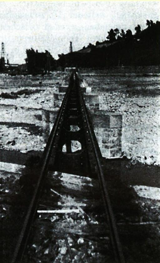
Abb. 69: Waldbahnbrücke mit gemauerten Pfeilern und Stahlträgern
