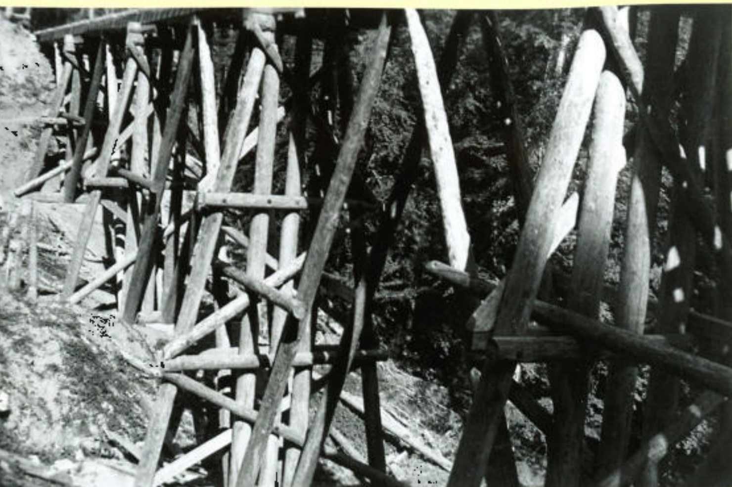
Abb. 63: Holztafel- und circulus-Sprengwerk im Deltal in einer anderen Ansicht (F. Hahn)
