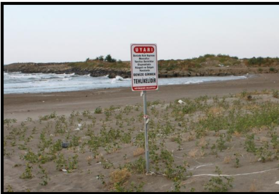
Foto 3. Dolgu alanı inşaatı başladıktan sonra kıyıda rip akıntıları artmış ve uyarı levhaları asılmıştır.
