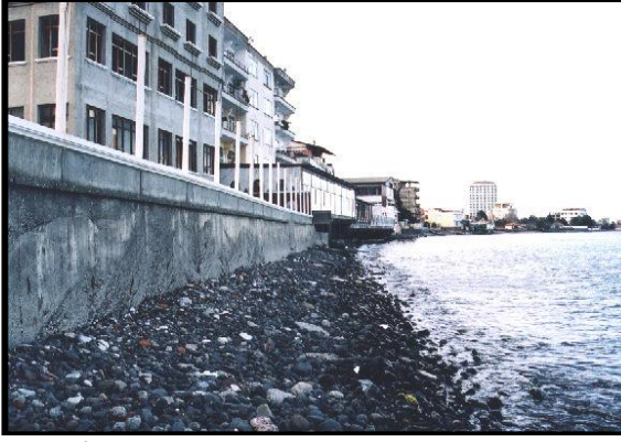
Foto 6. Körfez mahallesinde mevzuata uymayan binalar.
