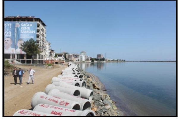
Foto 7. Körfez mahallesinde mevzuata aykırı binalara alt yapı götürme çalışmaları.
