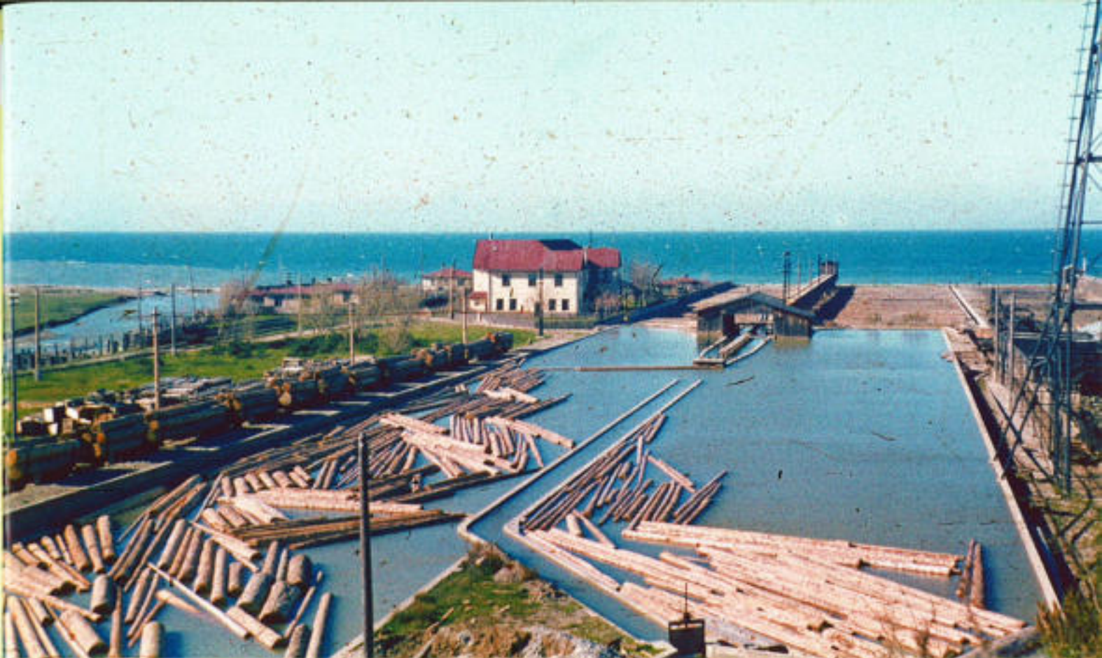
Abb. 129 Der Klatzsch liegt direkt am Meer. Im Seilbahnmast ist das Gewicht zur Seilspannung zu erkennen. Das große Gebäude im Hintergrund links beherrscht die Verwaltung von Sägewerk und Transporteinrichtungen.
