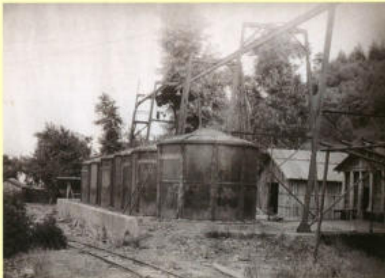
Abb. 123 Der Holzverkohlungsbetrieb ist durch eine kurze Stichstracke an das Sägewerk angeschlossen. Hier werden Holzstäbe aus der Produktion zu Holzkohle und Teer veredelt. Eine Eisenbahnbahn sorgt für die Beschickung der eisernen Ofen.
