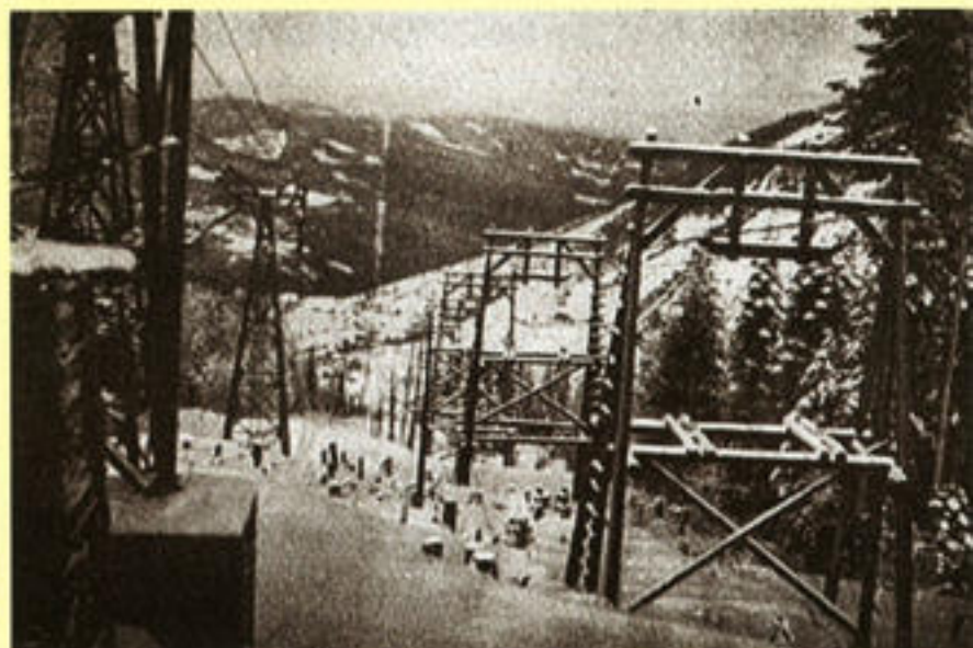
Abb. 113 Ein Bild aus der Bauzeit der Bleicherl-Seilbahn: zum leichteren Materialtransport wurde parallel zur Strecke eine temporäre Hilfsseilbahn der Firma Pohlig mit Holzmasten errichtet. Nach Fertigstellung der Bleicherl-Seilbahn wurden die Teile für den Bau der Seilbahn Yemişli – Karadere verwendet (Franz Heferer).
