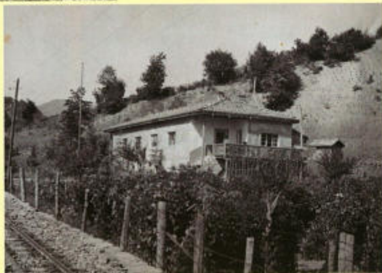
Abb. 116 Die Täler sind recht erg. daher sind an allen geeigneten Stellen kleine Forsten angelegt. Für einen reibungslosen Betrieb benötigt die Walzahn die Ziegel AG auch viele Ausweich- und Abstellbahnhöfe. Auf diesem Bild ist die Station in Kazköy zu sehen: hier sind nicht nur Wohnungen für die Verwaltungsbeamten und eine kleine Backstube untergebracht, die Station dient auch als Sammelstelle für den Transport der Arbeiter in die Wälder
