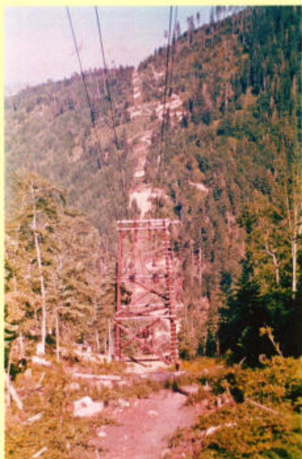
Abb. 109 Die S-recke der Pohlig-Seilbahn Yemişli – Karadere. Die Holzmasten fügen sich gut in das steile Gelände hinein, der Bau einer Drahtbahn wäre hier nur unter sehr hohen Aufwendungen möglich.
