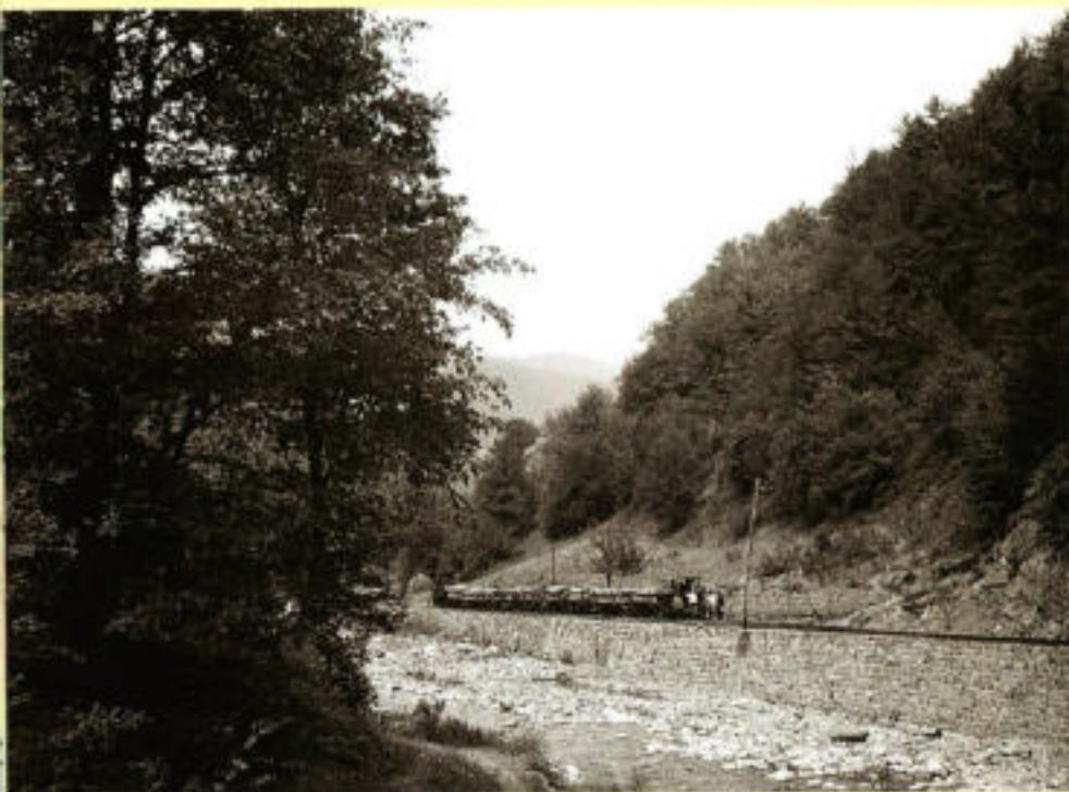
Abb. 114 Ein beladener Holzzug auf dem Weg zum Sägewerk. Die Mannschaft nutzt den leeren, abgekoppelten Tender zur Mittahrt. Beachtenswert sind auch die aufwendig erstellte Stützmauer und die Telefonleitung.
