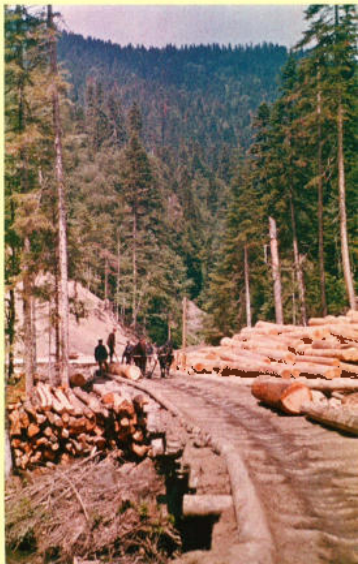
Abb. 105 Gut ist die gewässerte Schleifspur zu erkennen, die den Holztransport deutlich erleichtert und dabei auch das Holz vor Rissen und anderen Beschädigungen schützt.
