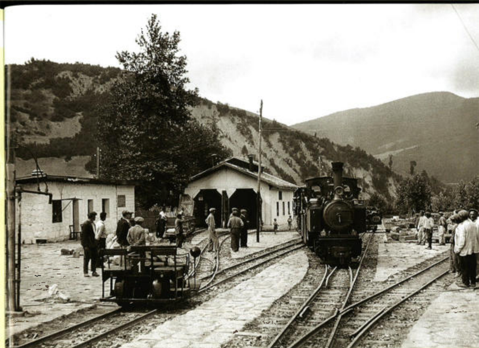
Abb. 16 Die Station von Yeniköy war ein wichtiger Trennungsbahnhof auf dem Weg ins Gebirge. Bahnverwaltung, Lokschuppen und Behandlungsanlagen sind hier zu finden. Links im Bild ein kleiner Wasserkran.
