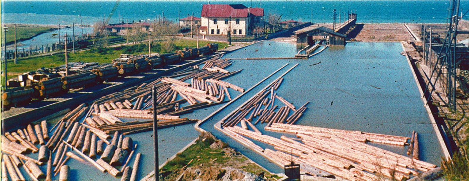
Abb. 129 Der Klotzteich liegt direkt am Meer. Im Seilbahnmast ist das Gewicht zur Seilspannung zu erkennen. Das große Gebäude im Hintergrund links beherbergt die Verwaltung von Sägewerk und Transporteinrichtungen.
