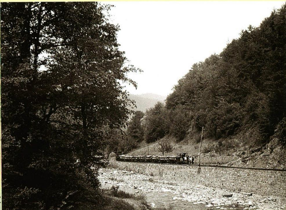
Abb. 114 Ein beladener Holzzug auf dem Weg zum Sägewerk. Die Mannschaft nutzt den leeren, abgekoppelten Tender zur Mitfahrt. Beachtenswert sind auch die aufwendig erstellte Stützmauer und die Telefonleitung.
