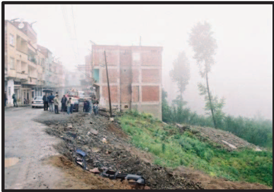
Foto 8-9. Şehrin güneydoğu çıkışında heyelan nedeniyle yıkılan çok katlı evler. Birinin enkazı bile kalmamış, diğerinin beton kaidesi kalmış. Bu cadde üzerinde korku içinde yaşayan vatandaşlar buradaki heyelanların esas sebebi olarak delik deşik olduğu için oldukça yoğun su kaçağına sahip olan yetersiz altyapıyı görmekte ve bu nedenle belediyeyi suçlamaktadırlar.
