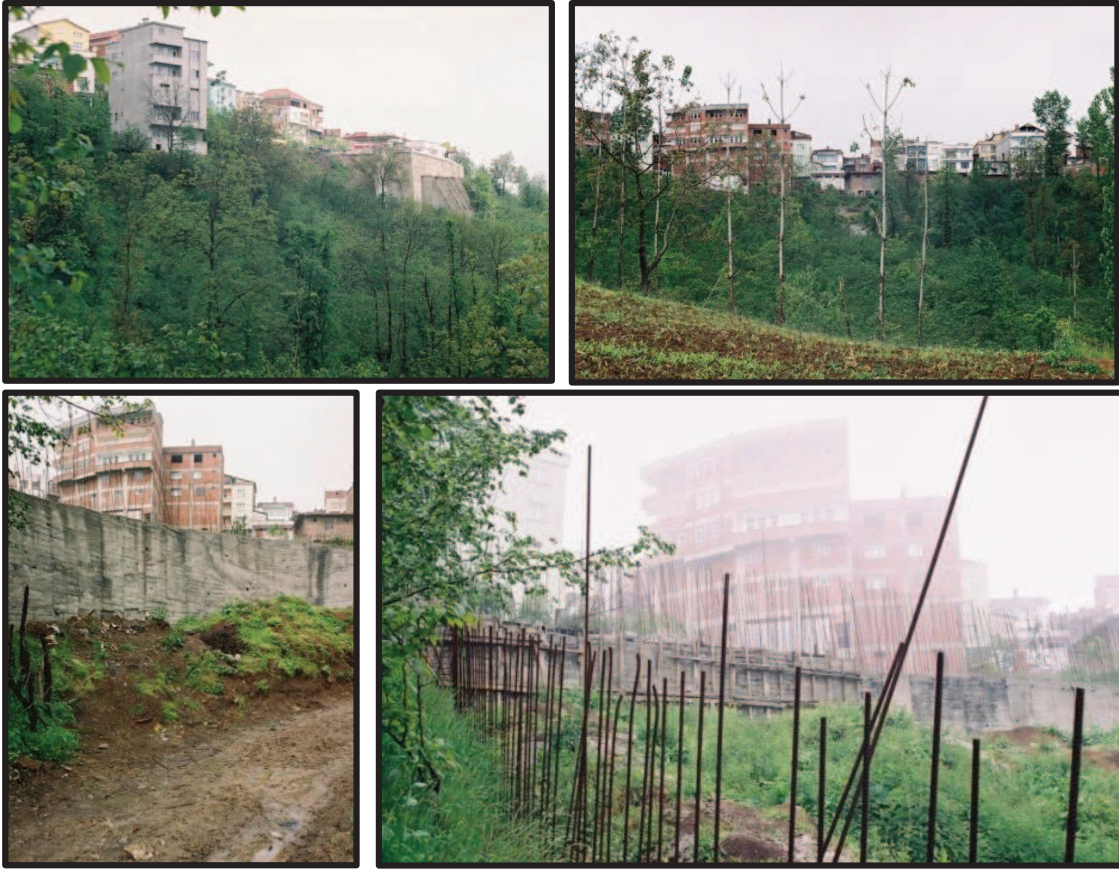
Foto 10-11-12-13. Şehrin güneydoğu kesiminde yamaç dengesini bozulması ile binalar adeta havada asılı gibi durmakta, sürekli heyelan endişesi taşıyan vatandaşlar ana kayaya oturmadığını bile bile büyük masraflarla beton setler yapmaya devam etmektedirler.
