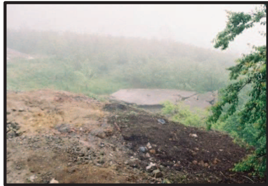
Foto 8-9. Şehrin güneydoğu çıkışında heyelan nedeniyle yıkılan çok katlı evler. Birinin enkazı bile kalmamış, diğerinin beton kaidesi kalmış. Bu cadde üzerinde korku içinde yaşayan vatandaşlar buradaki heyelanların esas sebebi olarak delik deşik olduğu için oldukça yoğun su kaçağına sahip olan yetersiz altyapıyı görmekte ve bu nedenle belediyeyi suçlamaktadırlar.
