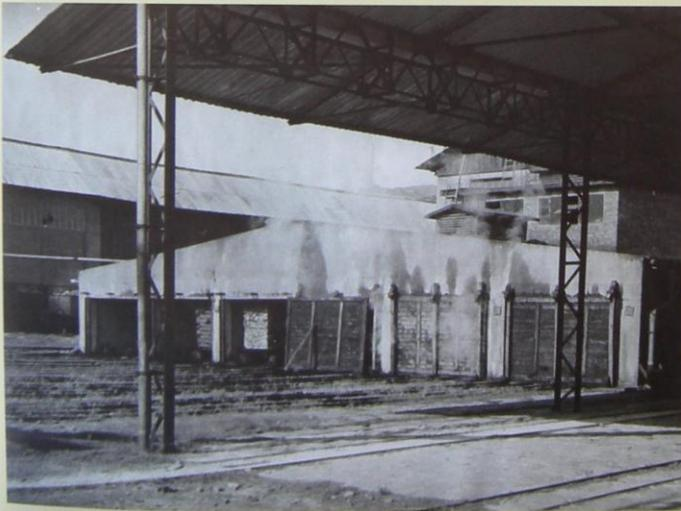
Abb. 173 Die Dämpfungsanlage für Buchenholz wird vom Abdampf der Heizkessel gespeist.
