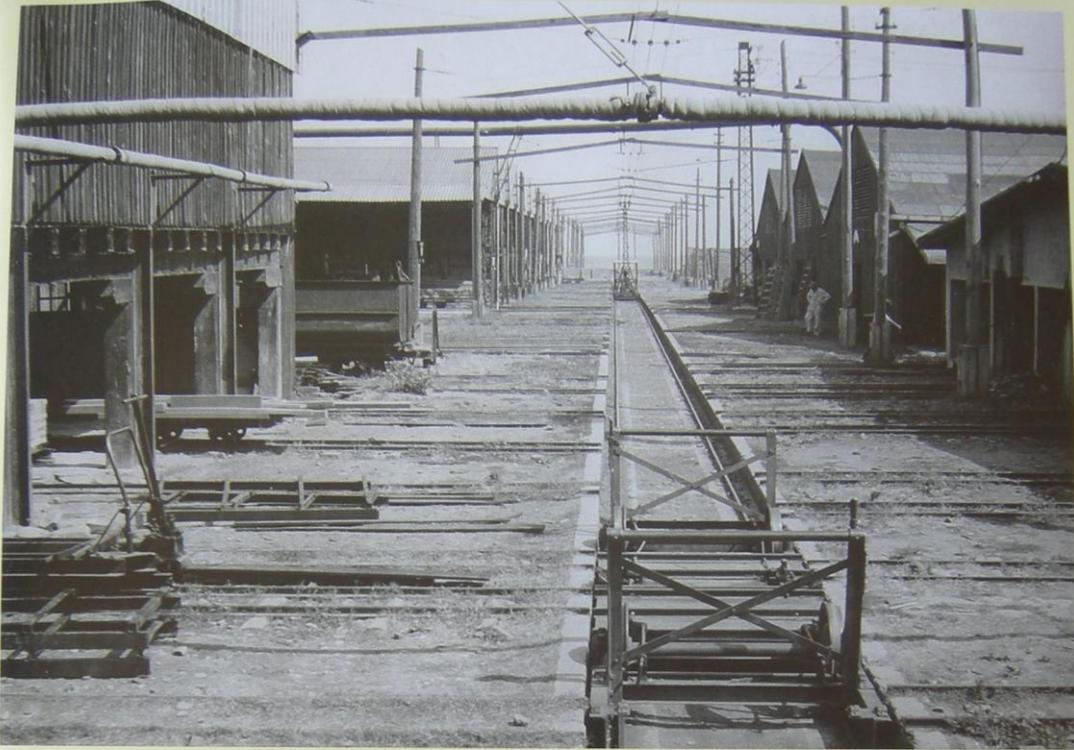
Abb. 172 Die Schiebebühne 16 wird auch zum Transport der Produkte der Hartholzsäge verwendet.
