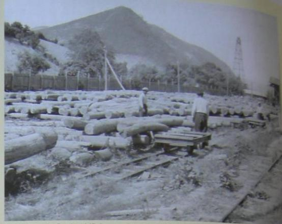
Abb. 170 Die Buchenblöcke werden per Handkarren vom Klotzlagerplatz 34 über Gleis 35 zum Schrägaufzug 36 gebracht.
