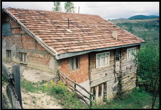
Foto 21,22,23,24. Ayancık ve Türkeli köylerinde ahşap evlerin duvarlarını korumak için alınan tedbirler; evlerin rüzgâr ve sulu sepeken alma riski yüksek taraflarının saca kaplanması (üstte), binanın bütünüyle sıvanarak ve boyanarak muhafaza altına alınması, alt kattaki ahırın konuta dâhil edilmesi, öndeki boşluğun garaj yapılması, camların plastik pencere ile yalıtımlı hale getirilmesi ve son olarak güneş enerji sisteminin kurulması (altta).
