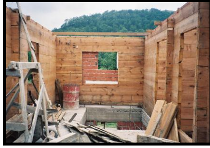
Foto 40,41,42. Ahşap evin söküldükten sonra betonarme bir binayı üçüncü katına inşası. İç kısım ahşap arada yalıtım ve dışta tuğla. Evin bitmiş haline bakıldığında durum hiç fark edilmiyor (Türkeli-Düzköy).
