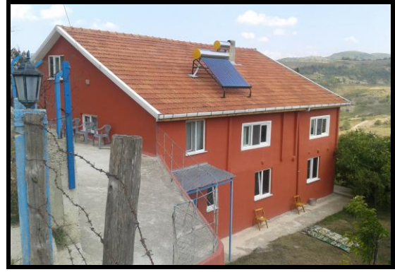
Foto 21,22,23,24. Ayancık ve Türkeli köylerinde ahşap evlerin duvarlarını korumak için alınan tedbirler; evlerin rüzgâr ve sulu sepeken alma riski yüksek taraflarının saca kaplanması (üstte), binanın bütünüyle sıvanarak ve boyanarak muhafaza altına alınması, alt kattaki ahırın konuta dâhil edilmesi, öndeki boşluğun garaj yapılması, camların plastik pencere ile yalıtımlı hale getirilmesi ve son olarak güneş enerji sisteminin kurulması (altta).
