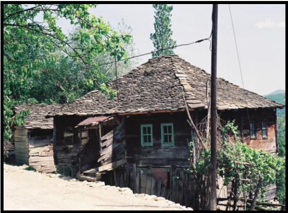
Foto 1,2,3,4,5,6. Araştırma sahasında taş örtülü ahşap meskenlerin orijinal (dışarıdan herhangi bir malzemenin henüz kullanılmadığı halleriyle) ayakta kalan son örnekleri.
