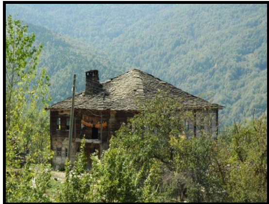
Foto 1,2,3,4,5,6. Araştırma sahasında taş örtülü ahşap meskenlerin orijinal (dışarıdan herhangi bir malzemenin henüz kullanılmadığı halleriyle) ayakta kalan son örnekleri.
