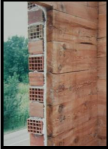
Foto 40,41,42. Ahşap evin söküldükten sonra betonarme bir binayı üçüncü katına inşası. İç kısım ahşap arada yalıtım ve dışta tuğla. Evin bitmiş haline bakıldığında durum hiç fark edilmiyor (Türkeli-Düzköy).
