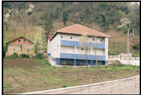
Foto 43,44. Ahşap evin sökülerek betonarme bir binanın ikinci katına inşa edilmesi. Bu binada ahşap kısım daha sonra sıvanarak kamufle edilmiştir. Bunun niçin yapıldığının ise izahı yoktur. Ahşap evin eski küçük pencerelerinin yeni binanın ikinci katındaki görüntüsünden başka eskiyi andıran hiçbir iz kalmamış gibi (Türkeli-Keşköy-Kestane Mh.).
