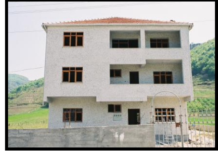
Foto 40,41,42. Ahşap evin söküldükten sonra betonarme bir binayı üçüncü katına inşası. İç kısım ahşap arada yalıtım ve dışta tuğla. Evin bitmiş haline bakıldığında durum hiç fark edilmiyor (Türkeli-Düzköy).
