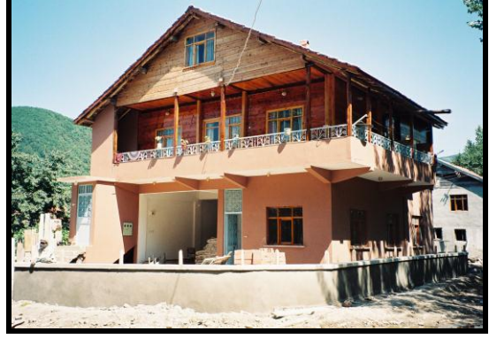
Foto 38,39. Ahşap bir evin sökülerek yeniden inşa edilmesi (Türkeli-Çatak köyü). Sökülmüş bir ahşap evin duvarlarının betonarme bir evin ikinci katında kullanılması, alt kat beton üst kat ahşap, (Çatalzeytin-Paşalı köyü).
